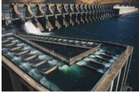
Figura N° 1: Escalera de peces John Day Lock and Dam.
