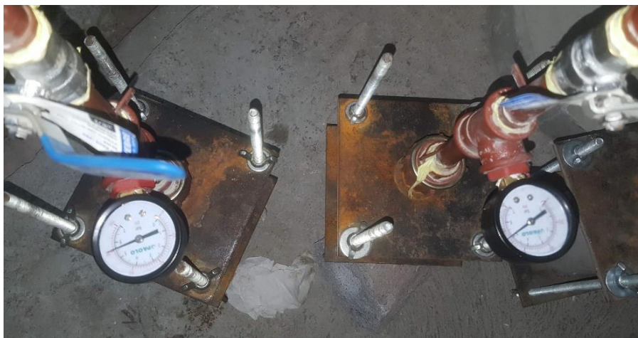
Fig. 2.27. Manómetros a 500 kPa (72.51 PSI) en ensayo de permeabilidad.
