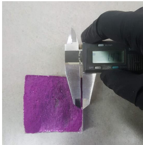
Fig. 2.37. Medición de zona carbonatada luego de ser rociada con Fenolftaleína.
