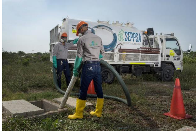
Figura 8. Limpieza del pozo séptico
