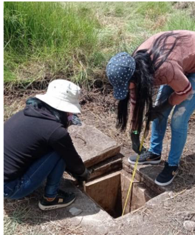
Figura 4. Toma de medidas de la caja de revisión
