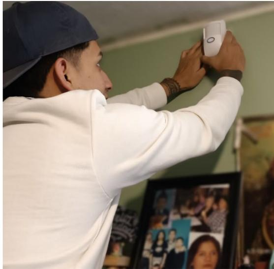
**Figura 3.68** Colocación del detector de movimiento
