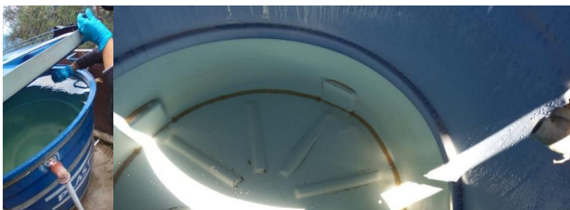
Figura 11 Sedimentación tanques de solución madre
