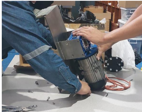
Figura 2, anexo IV. Instalación del Motoreductor. Fuente: (propia)
