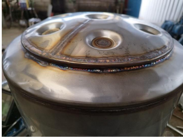
Figura 3.11. Construcción de tanque, soldadura TIG. Fuente: (propia)
