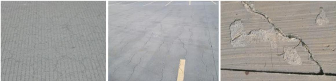
**Figura 1.** Fisuración en forma de mapa por contracción plástica y descamación
