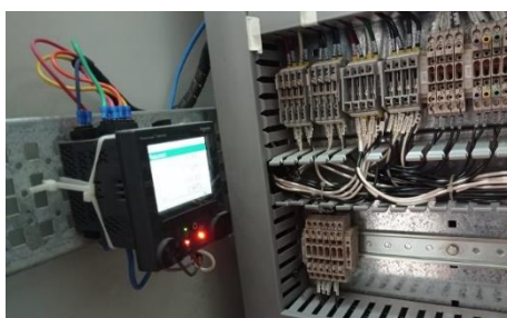
Figura 2.5. Instalación ION 7400
