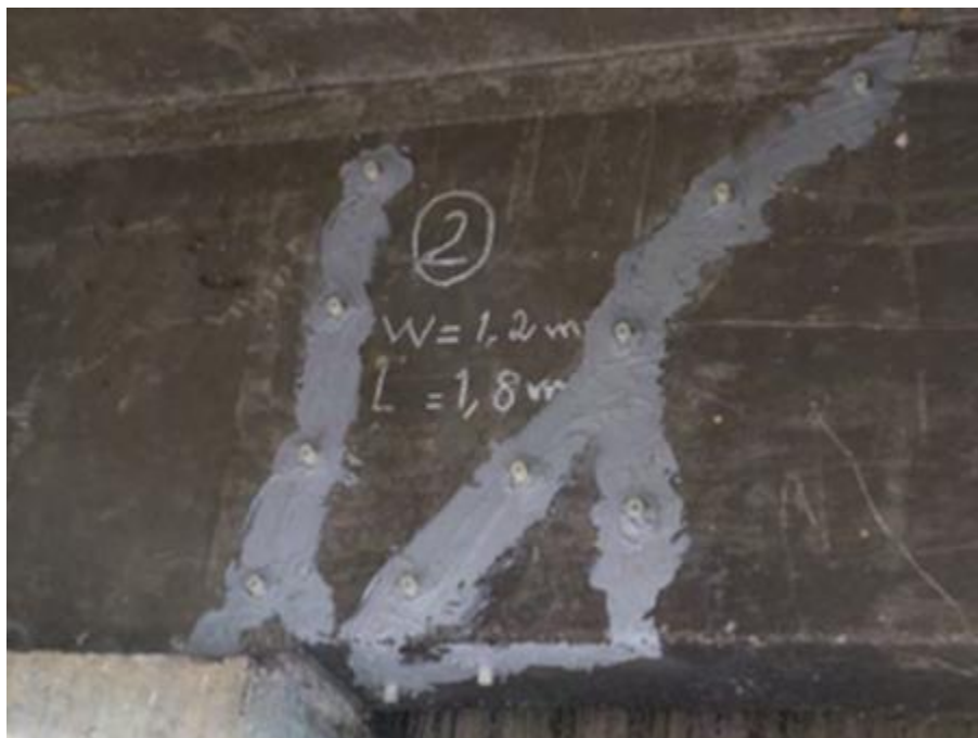
Figura 209. Material sellante aplicado en grietas.
