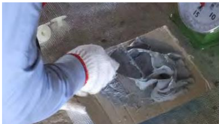
Figura 207. Material sellante luego de ser mezclado uniformemente.
