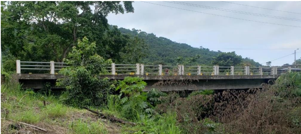
Figura 7. Puente tipo viga losa sobre el Río Mocora.
