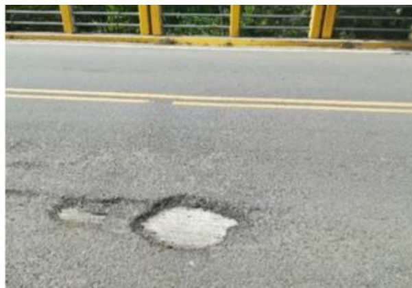
Figura 41. Vista de capa de rodadura del puente sobre el Río Mocora.
