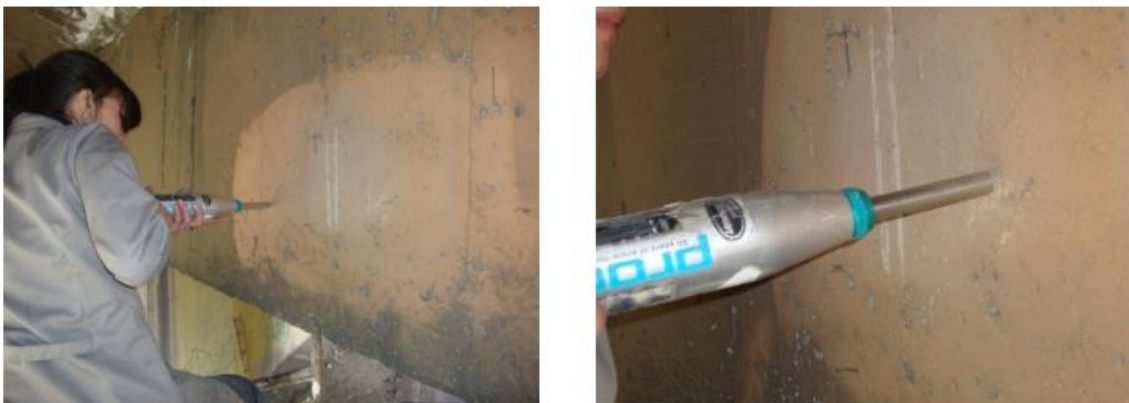
Figura 31. Uso del esclerómetro en el puente de Puengasí.
