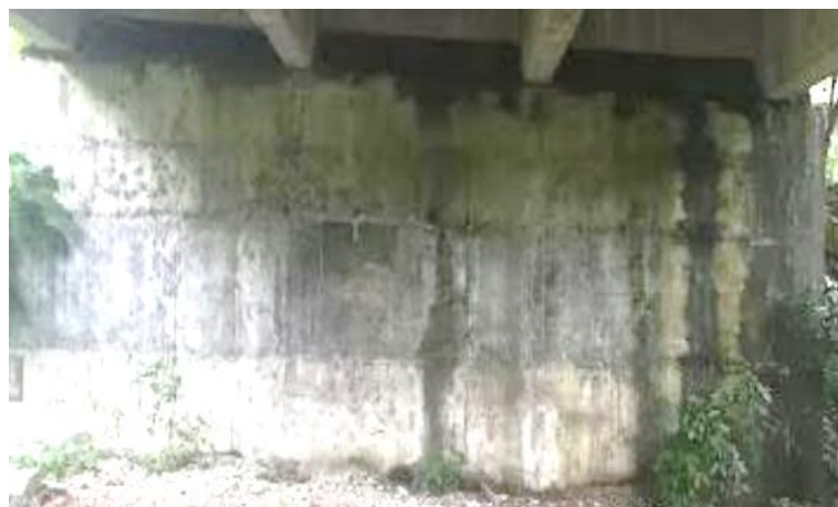
Figura 47. Vista del estado de las pilas tipo muro del puente sobre el río Mocora.
