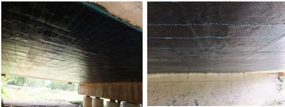
Figura 52. Reforzamiento terminado del tablero del puente Tro paing Sa-Ou, Preah Shanouk, Camboya.
