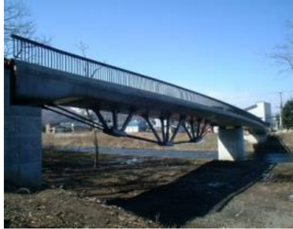
Figura 61. Vista inferior del postensado externo del puente Fégire en Suiza.
