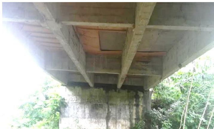
Figura 43. Vista de las vigas principal del puente sobre el Río Mocora.
