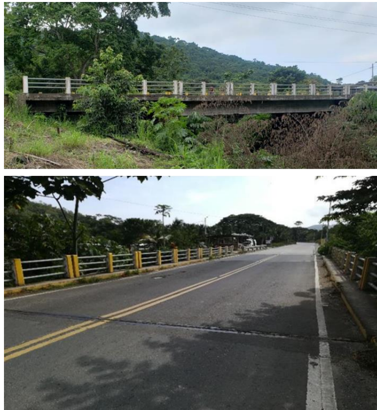
Figura 33. Vistas del puente sobre el Río Mocora en lateral y elevación, respectivamente.
