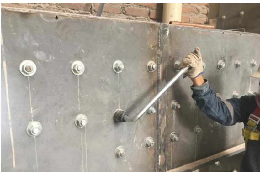
Figura 199. Control de ajuste de tuercas.
