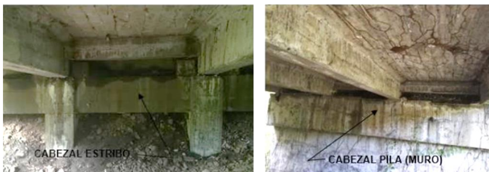
Figura 36. Vigas y diafragmas en el puente sobre el Río Mocora.
