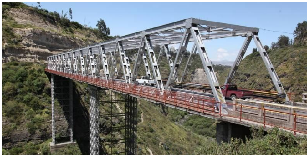
Figura 14. Puente de armadura sobre el Río Chiche.
