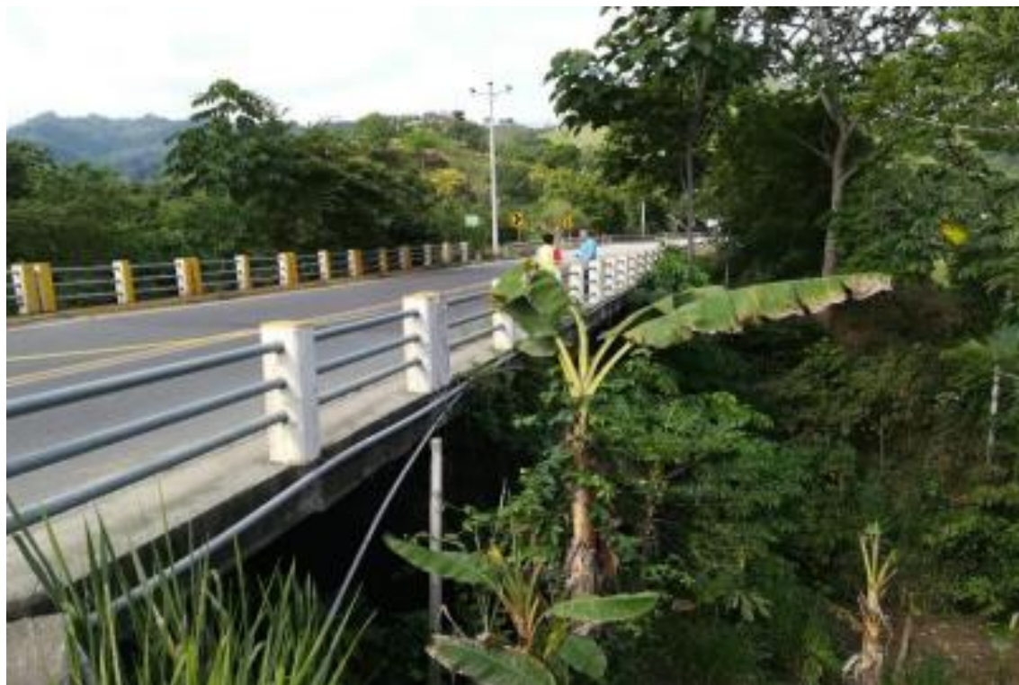
Figura 214. Acera y baranda del puente sobre el Río Mocora.
