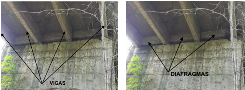
Figura 35. Vigas y diafragmas en el puente sobre el Río Mocora.
