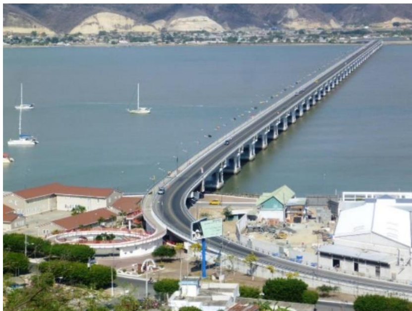
Figura 12. Puente de Bahía de Caráquez “Los Caras” en San Vicente.
