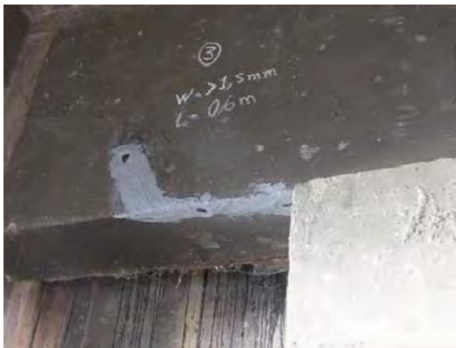
Figura 211. Reparación terminada de grieta en sección de hormigón.
