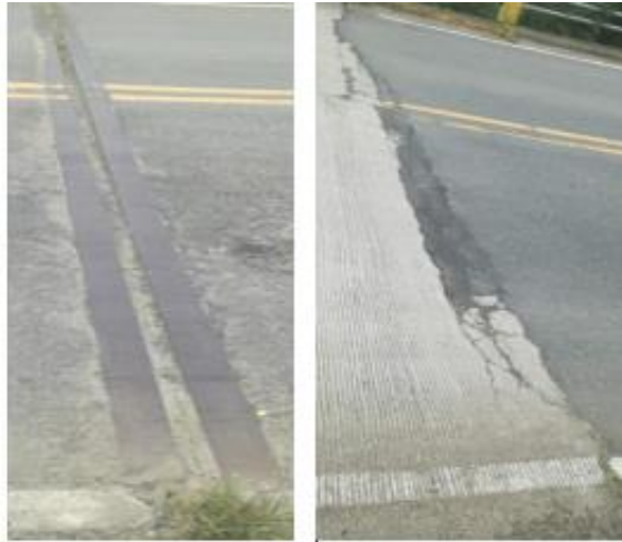
Figura 40. Vista de las juntas de expansión del puente sobre el Río Mocora.
