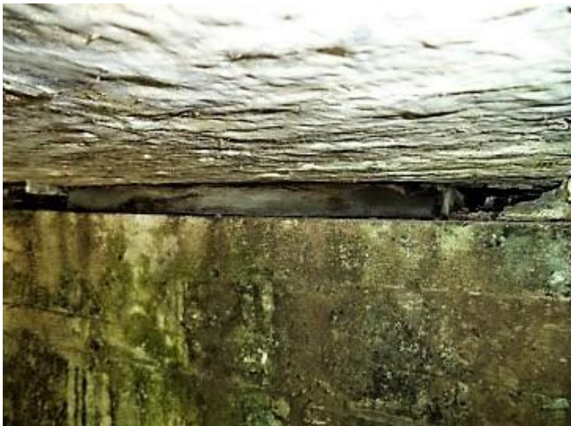
Figura 206. Apoyos de neopreno en el puente sobre el Río Mocora.
