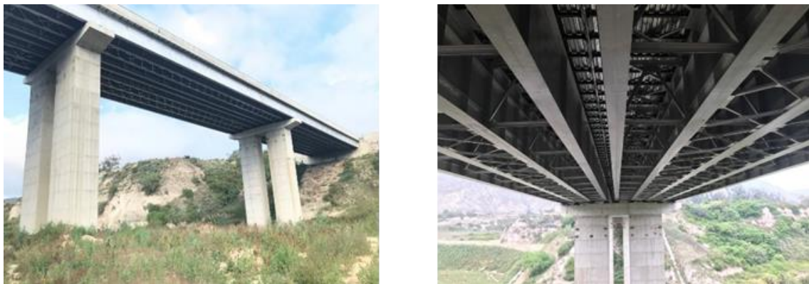
Figura 6. Vista lateral e inferior, respectivamente, del Puente Los Pájaros.
