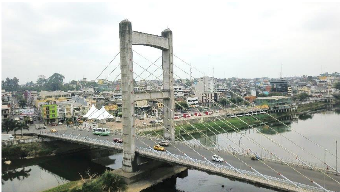
Figura 16. Puente Humberto Alvarado en Quevedo.
