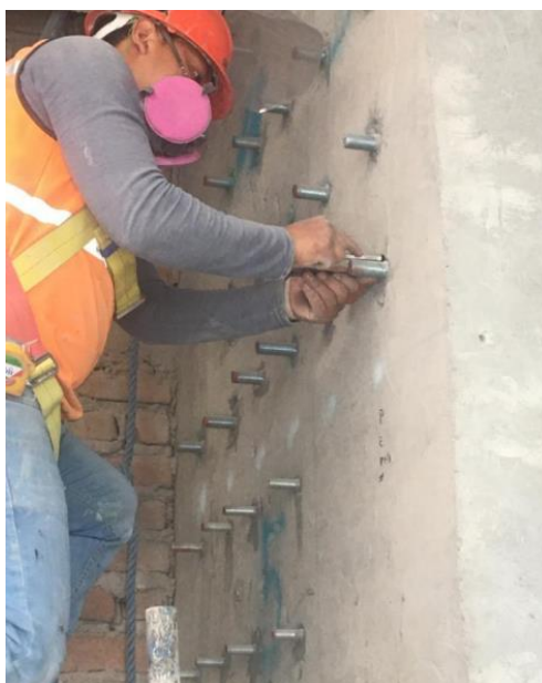
Figura 191. Colocación de varillas roscadas en los agujeros.
