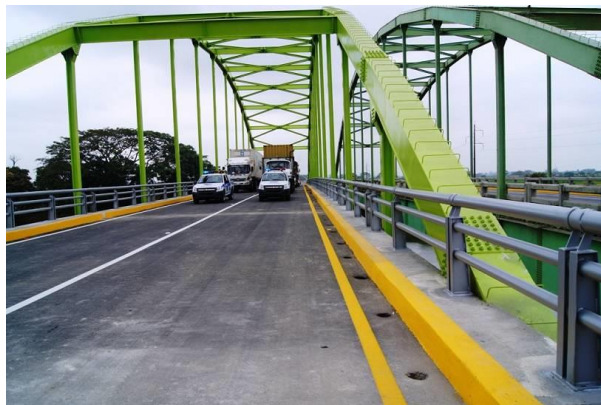
Figura 11. Puente acceso lateral Babahoyo.
