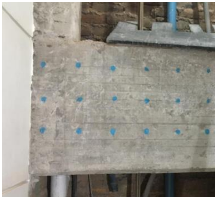
Figura 185. Señalización de agujeros previa a la perforación.
