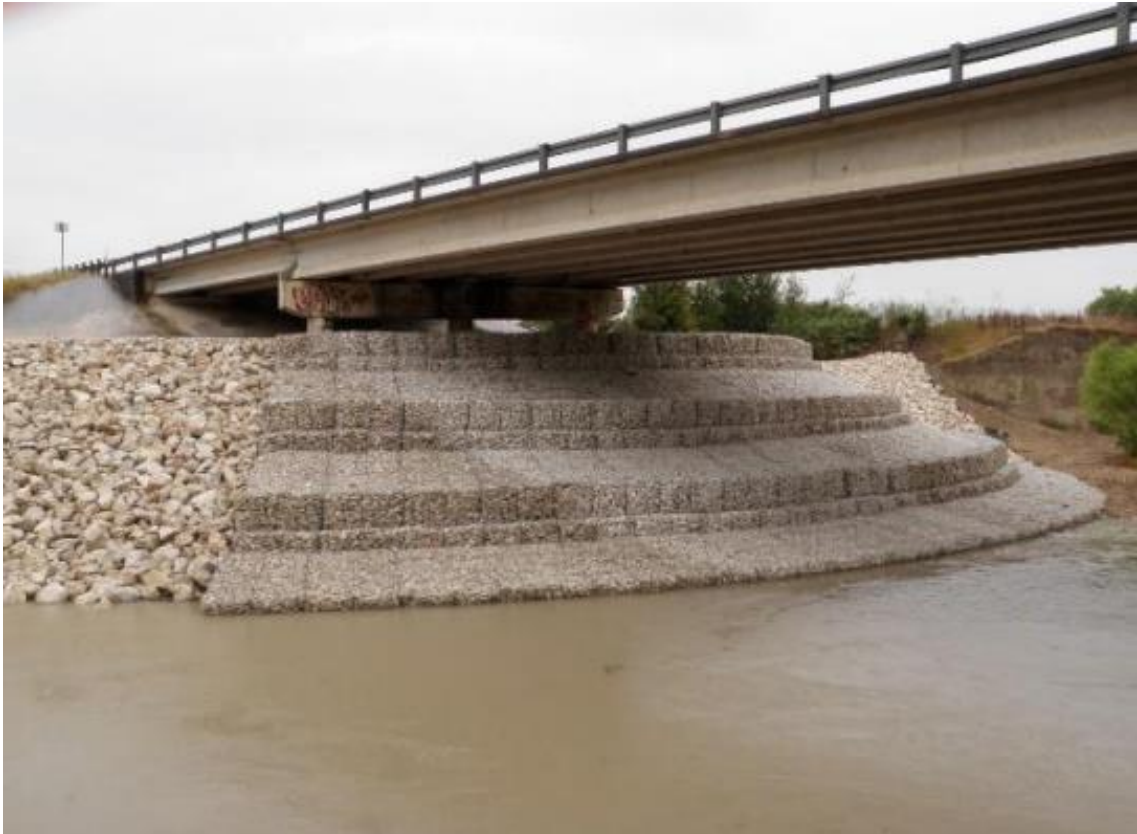
Figura 29. Protección contra la socavación al pie de pilas de puentes con la construcción de muros de gaviones.
