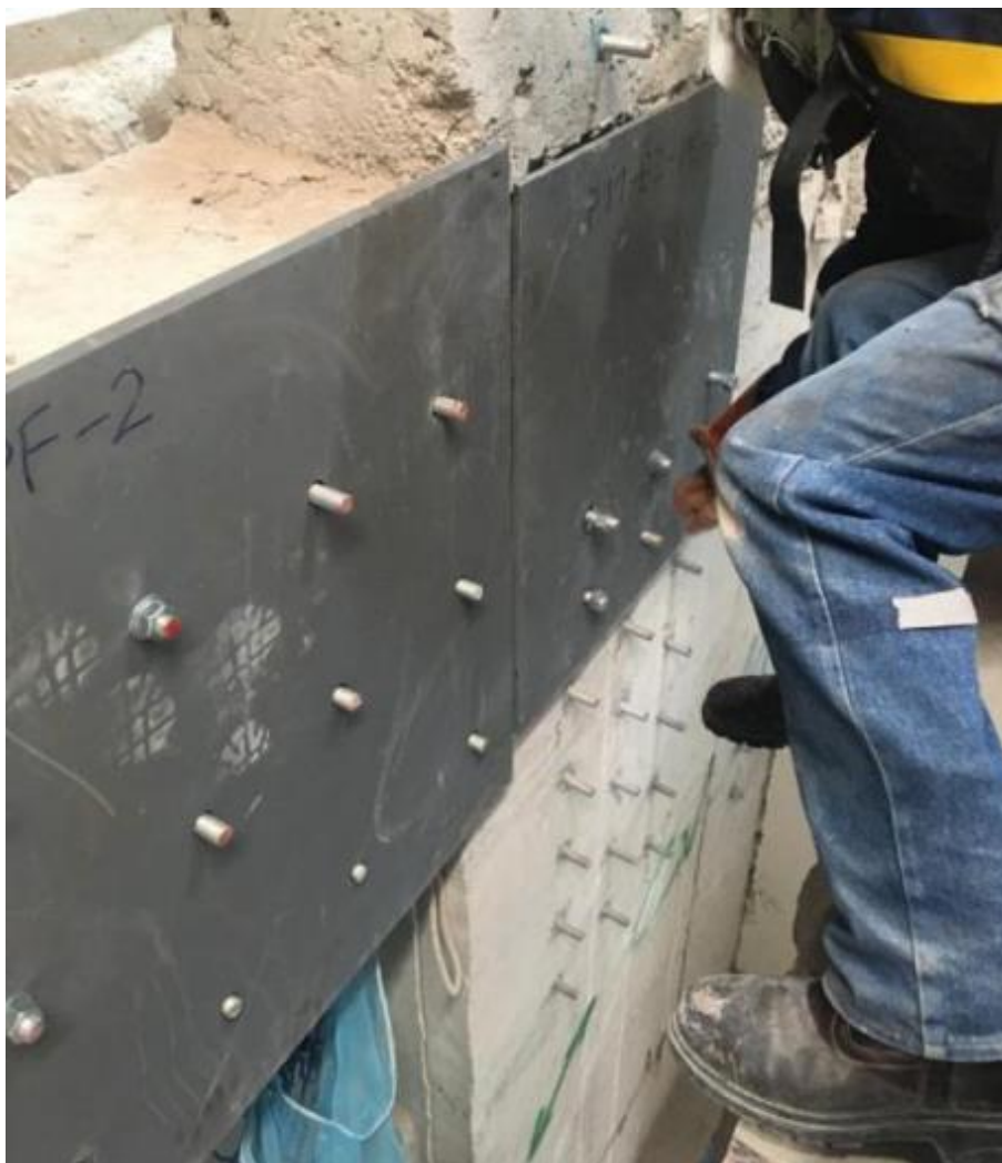
Figura 196. Colocación de placas de acero.
