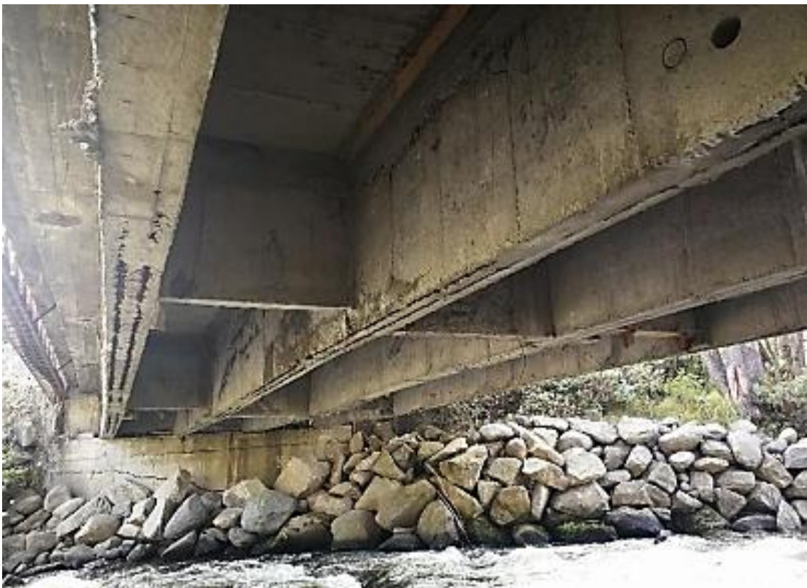
Figura 21. Superestructura del puente Ochoa León vista desde abajo.
