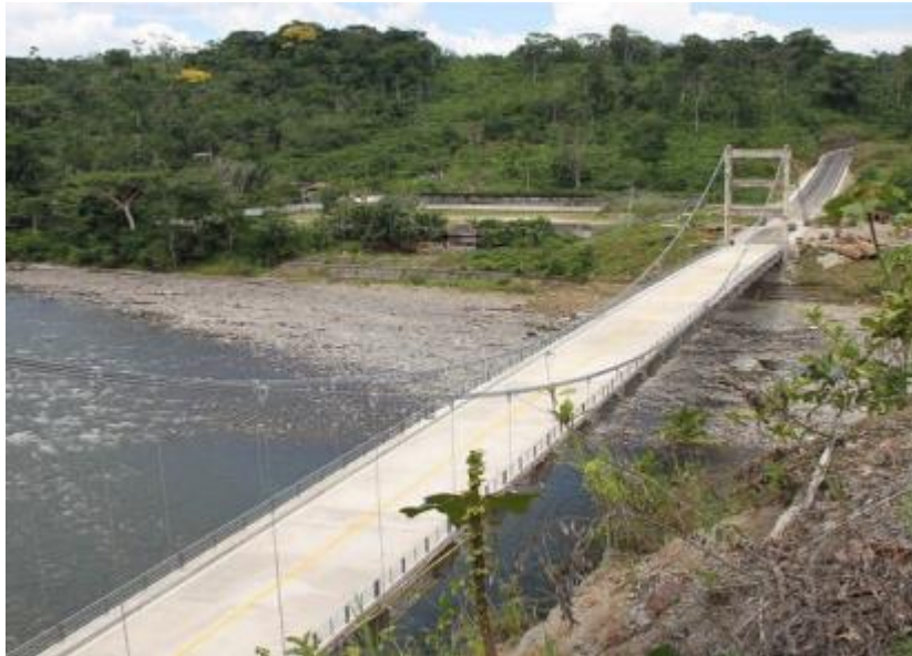
Figura 19. Puente sobre el Río Napo (Carretera E45).
