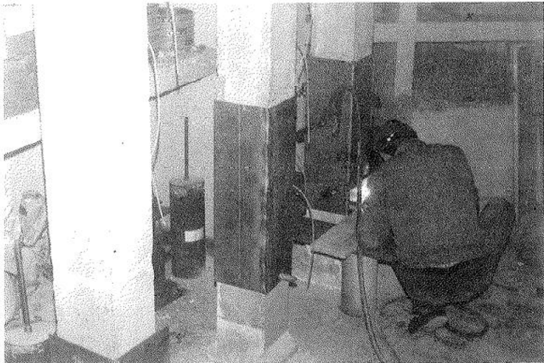
Figura 63. Columna encamisada con placas de acero soldadas e inyección de relleno.
