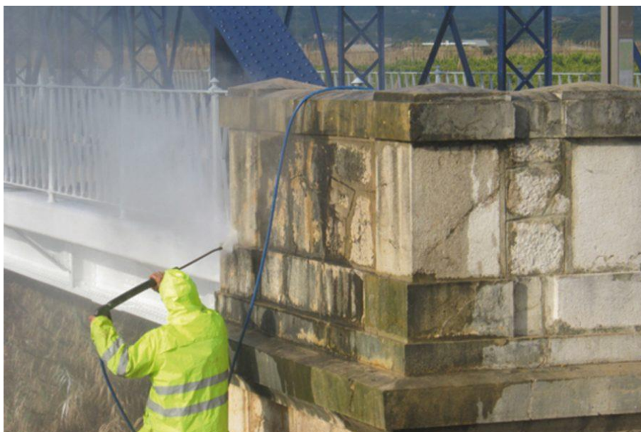
Figura 183. Limpieza de superficies de hormigón con agua a presión.
