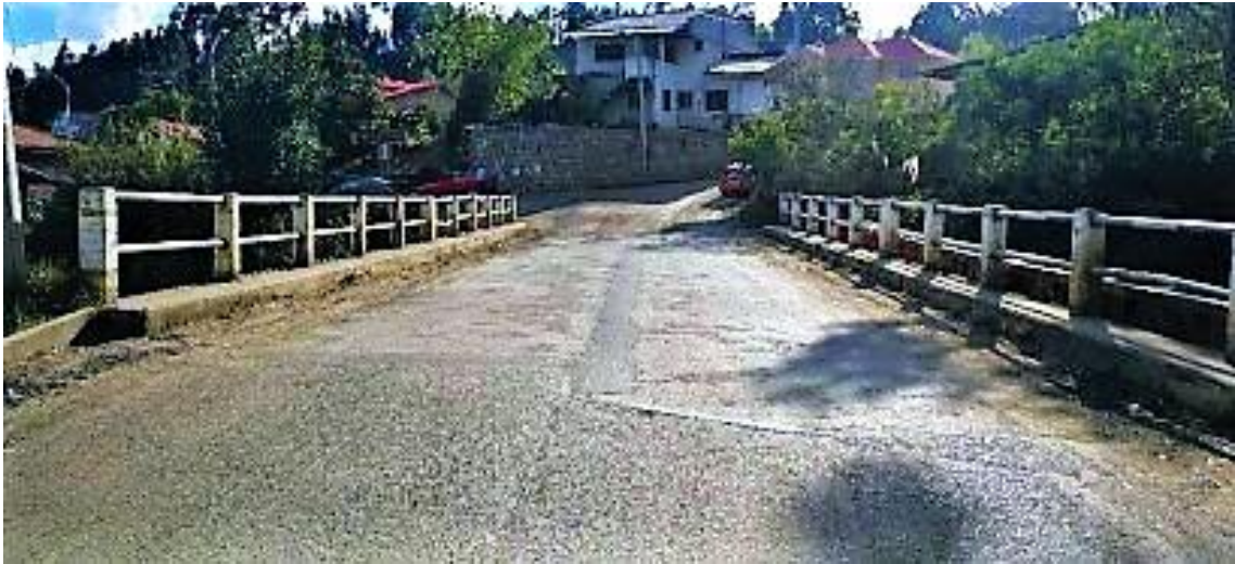
Figura 20. Superestructura del puente Ochoa León vista desde arriba.
