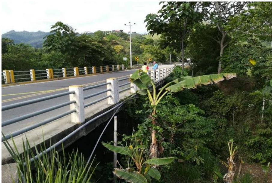
Figura 39. Vista de las barandas del puente sobre el Río Mocora.
