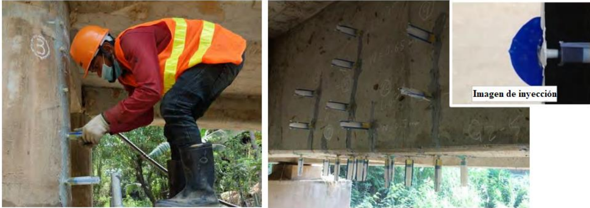
Figura 210. Inyección de resina epóxica en grietas.
