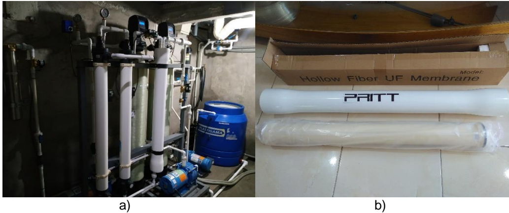
Figura 2.3. a) Tratamiento de agua residual con membranas de UF. b) Membrana UF 4040 con su carcasa.
