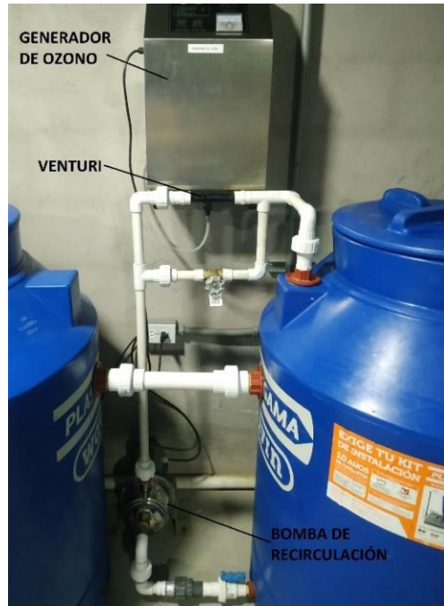
Figura 2.30. Montaje del sistema de recirculación de ozono.
