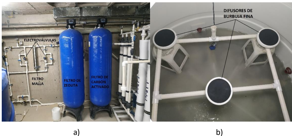
Figura 2.29. a) Montaje de los filtros y accesorios. b) Ensamblaje de difusores de aire y tubería.
