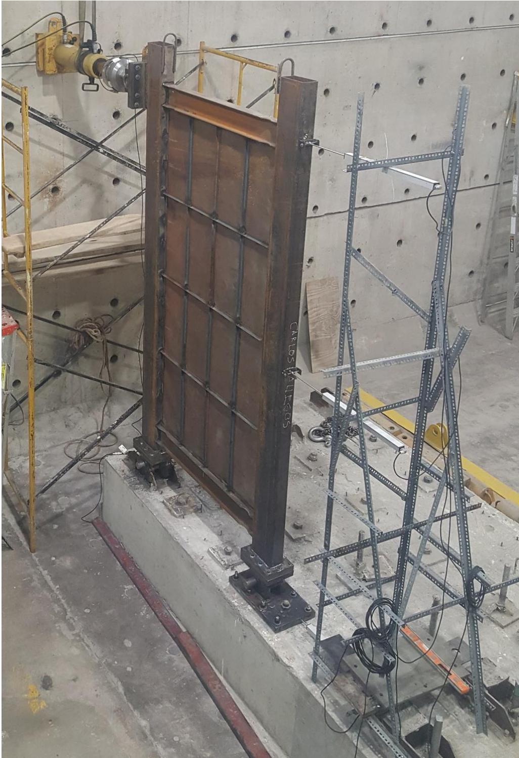
Figura 79. Instalación terminada de un muro SPSW rigidizado. Fuente: Elaborado por Carlos Gallegos.
