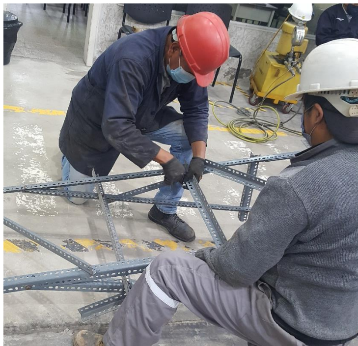
Figura 78. Preparación del soporte para LVDT's. Fuente: Elaborado por Carlos Gallegos.
