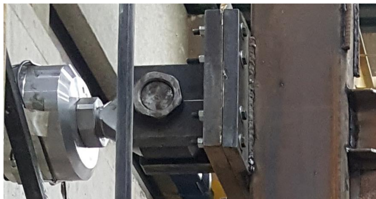
Figura 76. Acople instalado entre la celda de carga del gato hidráulico y la placa base previamente fijada en la columna. Fuente: Elaborado por Carlos Gallegos.
