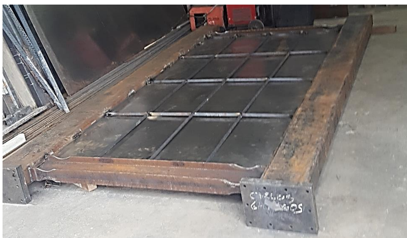
Figura 62. Panel de rigidizadores terminado en una cara del muro. Fuente: Elaborado por Carlos Gallegos.
