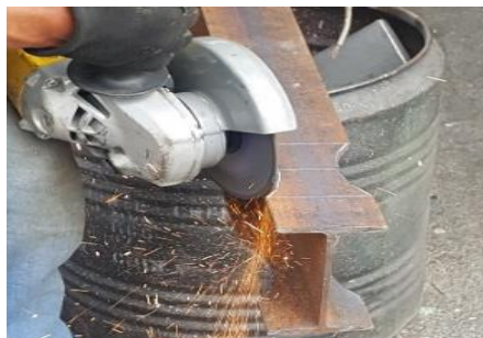
Figura 57. Moldeado de las secciones RBS en las vigas. Fuente: Elaborado por Carlos Gallegos.
