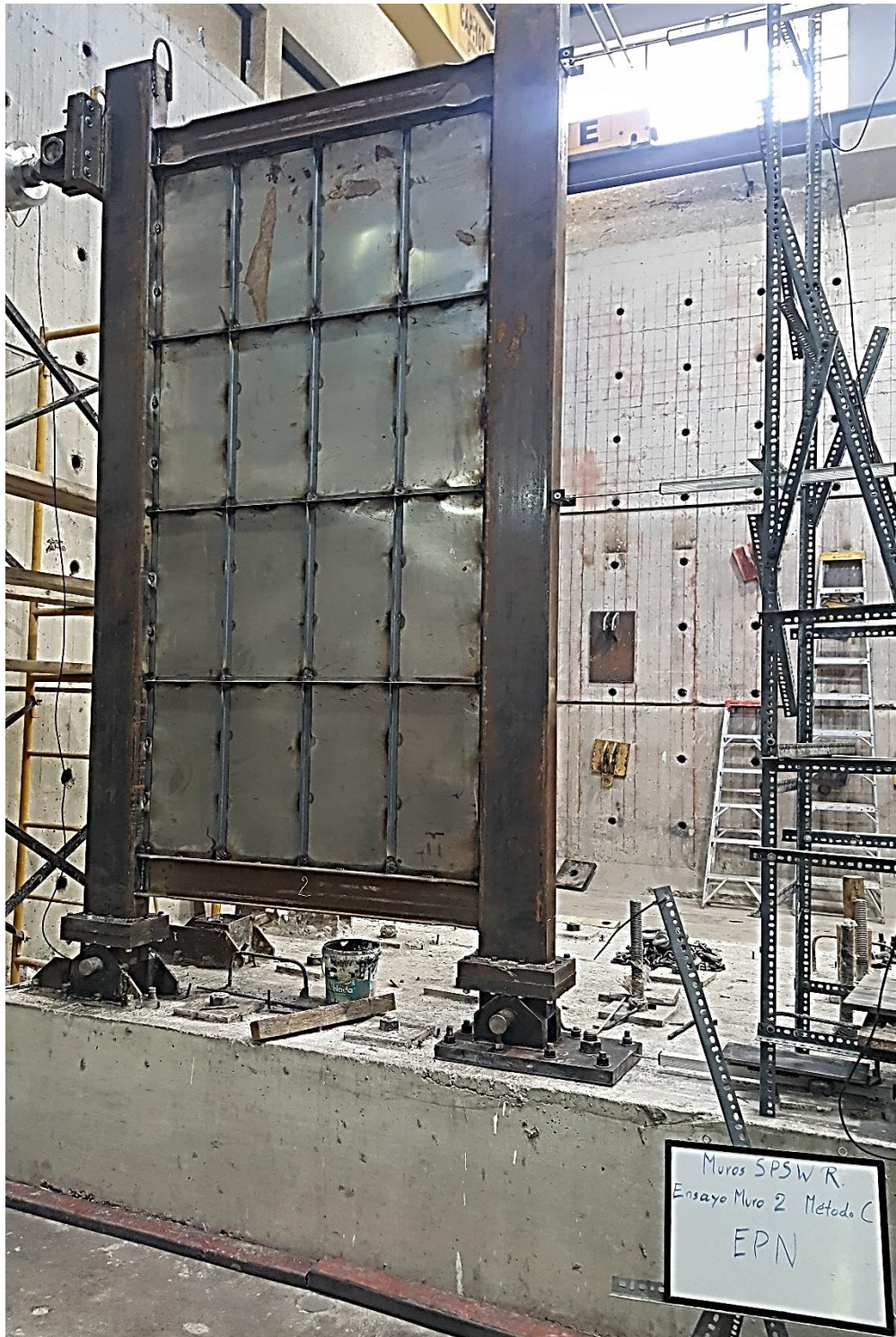
Figura 88. Muro SPSW rigidizado número 2: ensayo de cargas cíclicas por el método "C". Fuente: Elaborado por Carlos Gallegos.
