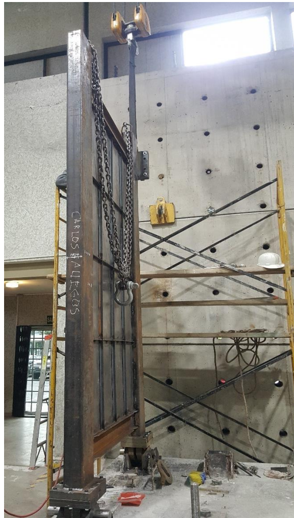
Figura 74. Muro colocado en la cimentación. Fuente: Elaborado por Carlos Gallegos.
