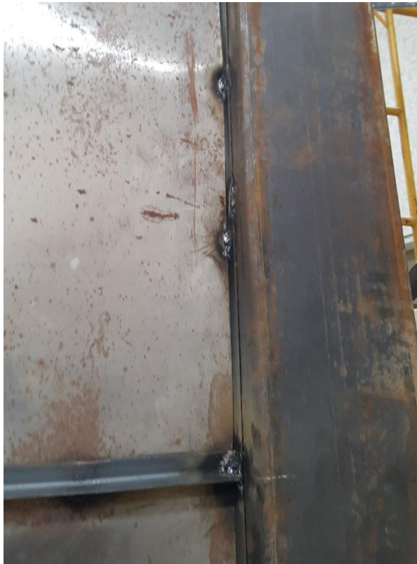
Figura 126. Acabado de suelda en el muro 3. Fuente: Elaborado por Carlos Gallegos.
