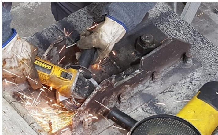
Figura 71. Cortado de restos encontrados en un empotramiento. Fuente: Elaborado por Carlos Gallegos.
