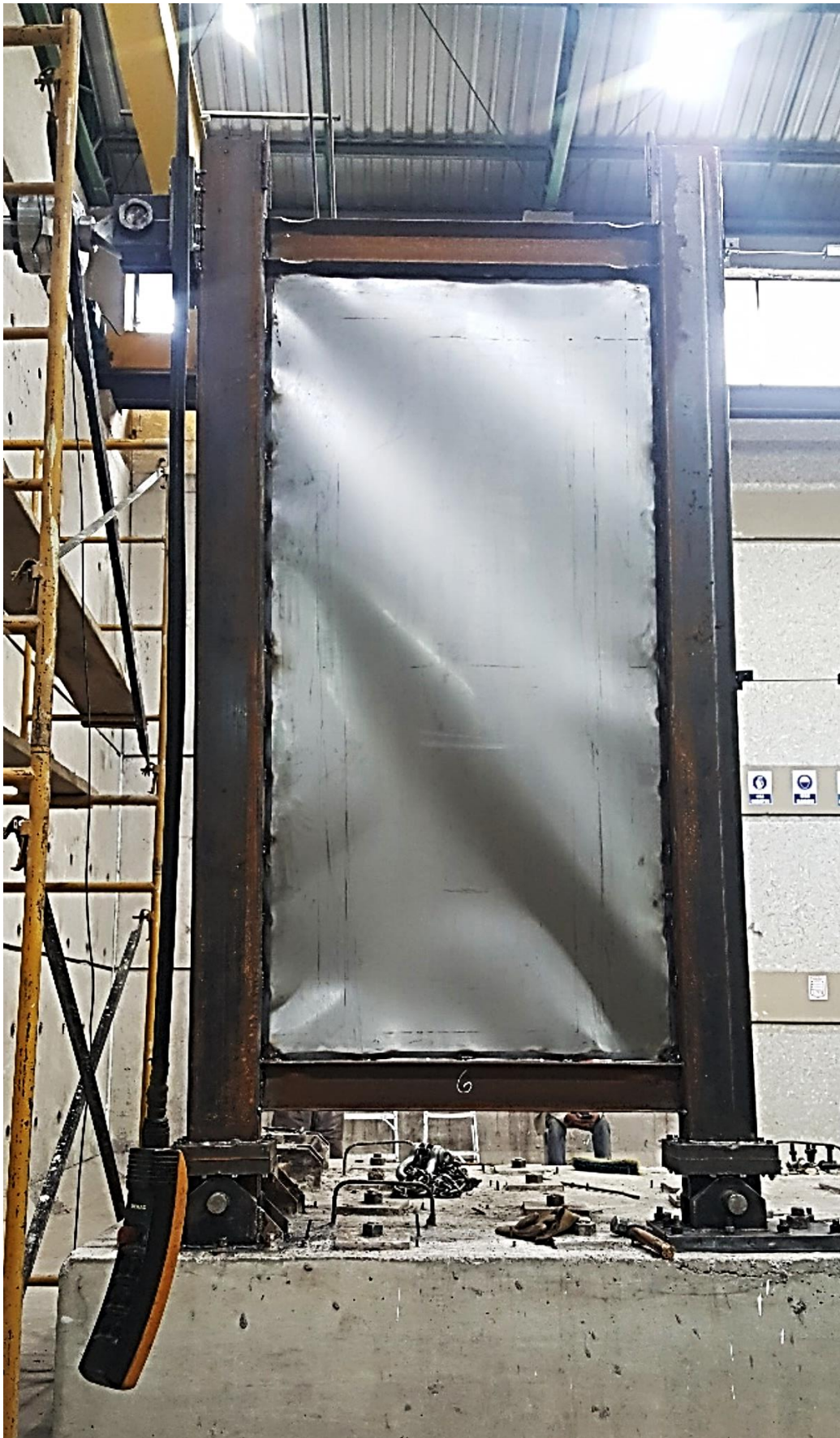
Figura 98. Muestra número 6 (muro SPSW) durante el ensayo de cargas cíclicas. Fuente: Elaborado por Carlos Gallegos.
