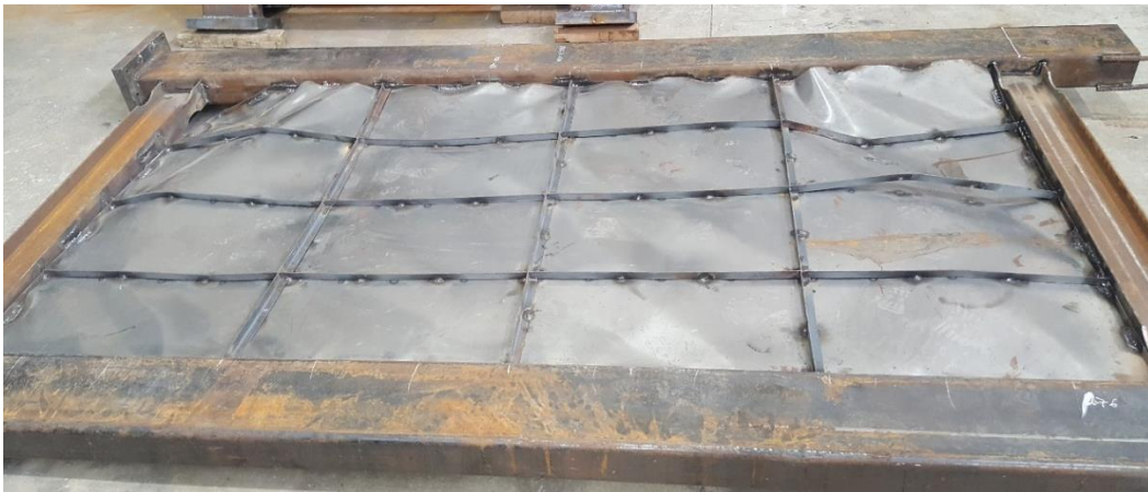
Figura 123. Muro SPSW rigidizado luego del ensayo. Fuente: Elaborado por Carlos Gallegos.
