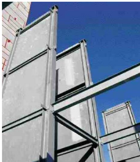
Figura 23. Ejemplo de muros SPSW en un edificio en construcción. Fuente: (Crisafulli, 2018).
