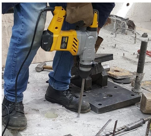
Figura 68. Perforado de los agujeros para la colocación de los pernos de anclaje. Fuente: Elaborado por Carlos Gallegos.
