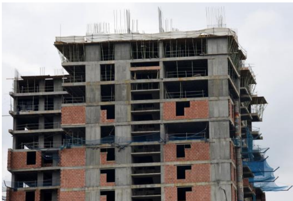
Figura 12. "Obra gris" de un edificio de hormigón armado en construcción. Fuente: (Múnera, 2018).
