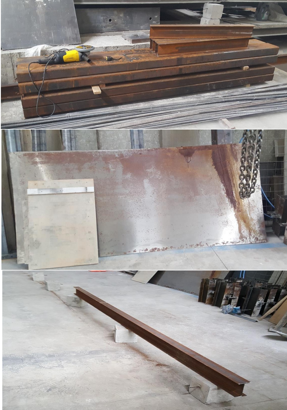
Fotografía 1: Corte de perfiles para el ensamblado de los muros.
