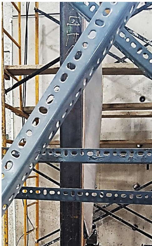
Figura 128. Pandeo de la placa de acero luego del ensayo. Fuente: Elaborado por Carlos Gallegos.
