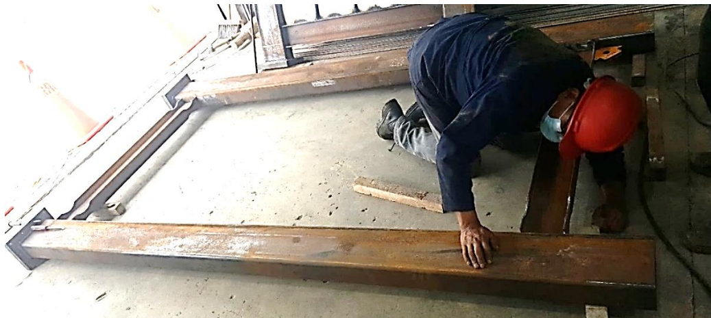
Figura 59. Montaje de uno de los pórticos para los muros SPSW rigidizados. Fuente: Elaborado por Carlos Gallegos.
