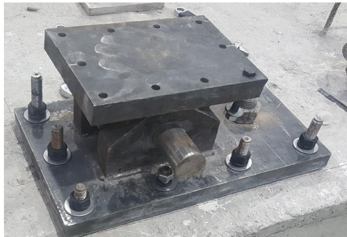
Figura 70. Rótula mecánica sujeta con los pernos de anclaje. Fuente: Elaborado por Carlos Gallegos.
