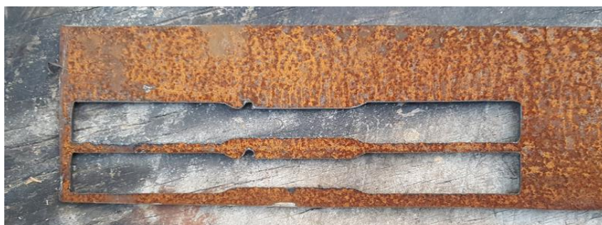
Figura 81. Alma de la viga IPE 140 luego de la extracción de las muestras. Fuente: Elaborado por Carlos Gallegos.
