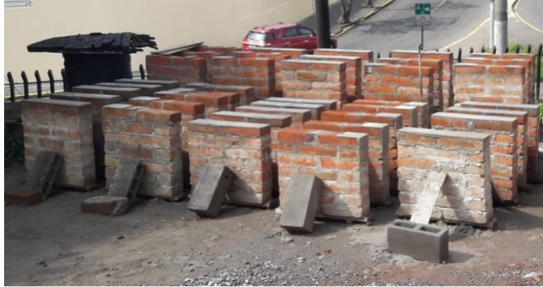
Figura 34. Muretes construidos para ensayos de compresión y tensión
