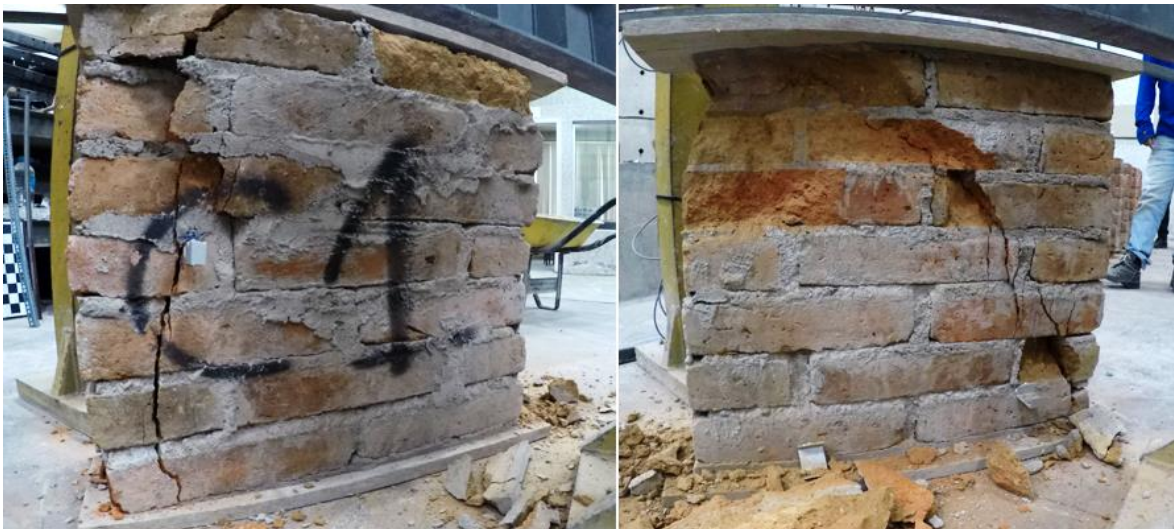
Figura 42. Falla general a compresión de muretes de mampostería
