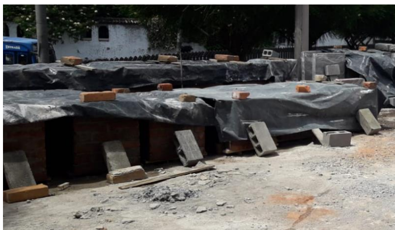
Figura 35. Curado de muretes de ladrillo
