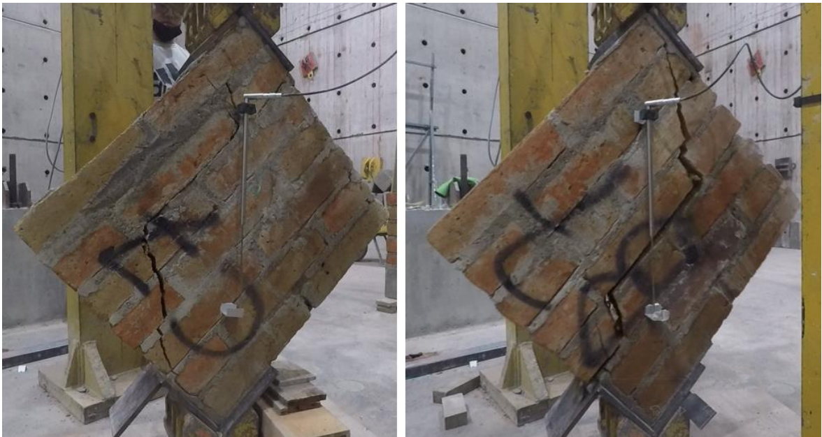
Figura 48. Falla general a tensión de muretes de mampostería
