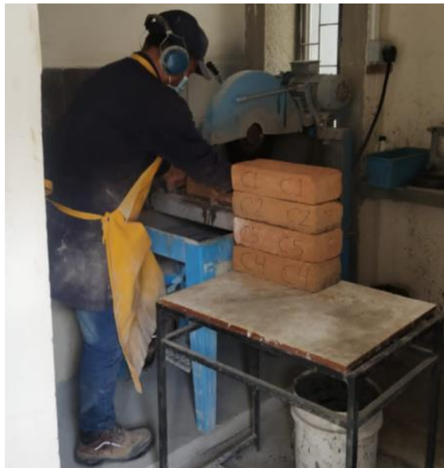
Figura 28. Corte de unidades de ladrillo por la mitad de su longitud.
