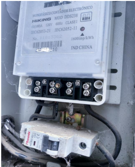
Figura 6.17 Fase sale directo de la bornera al térmico sin pasar por el contador de energía
