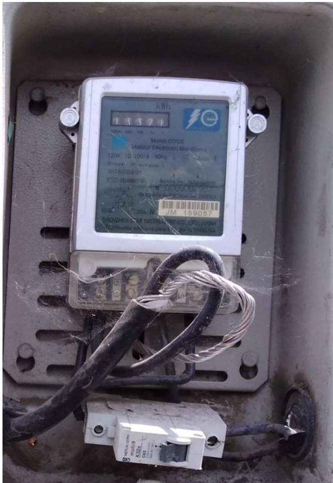
Figura 6.12 Fase sale directo del borne al térmico sin pasar por el medidor
