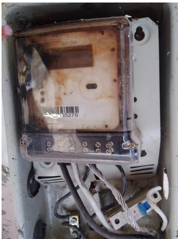
Figura 6.11 Medidor averiado
