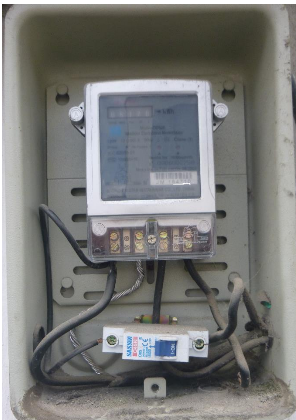
Figura 6.17 Fase sale directo de la bornera al térmico sin pasar por el contador de energía
