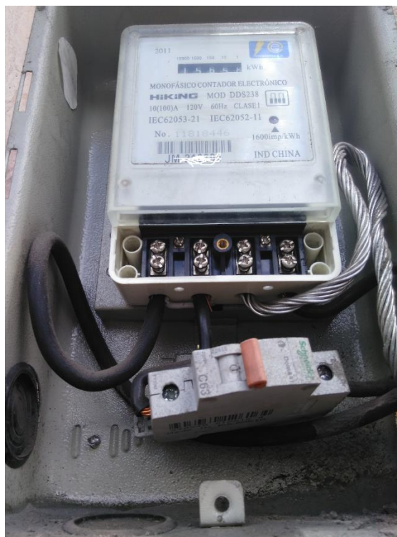
Figura 6.18 Fase con un puente entre la entrada y la salida del medidor
