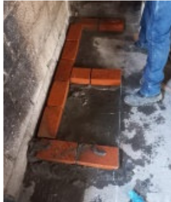
Figura 3.4. Colocación de la primera fila de ladrillos.
