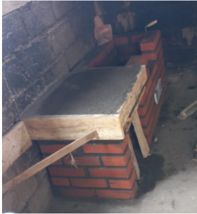
Figura 3.6. Encofrado de seguridad (Fuente: propia)
