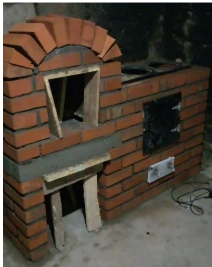
Figura 3.9. Formación de la cúpula del horno
