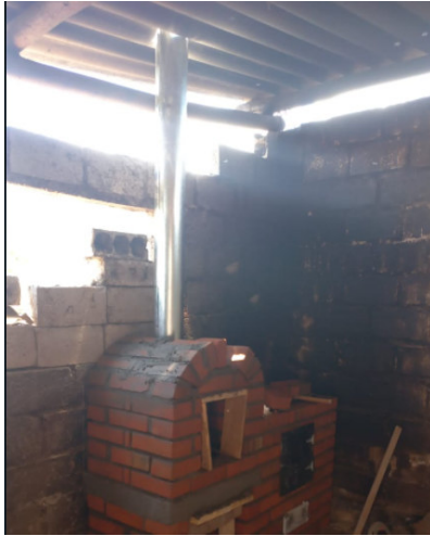
Figura 3.10. Colocación de la chimenea (Fuente: propia)
