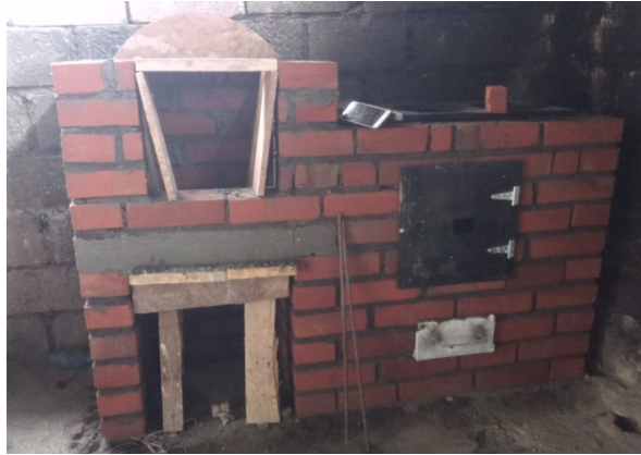
Figura 3.8. Encofrado para sostener la cúpula del horno
