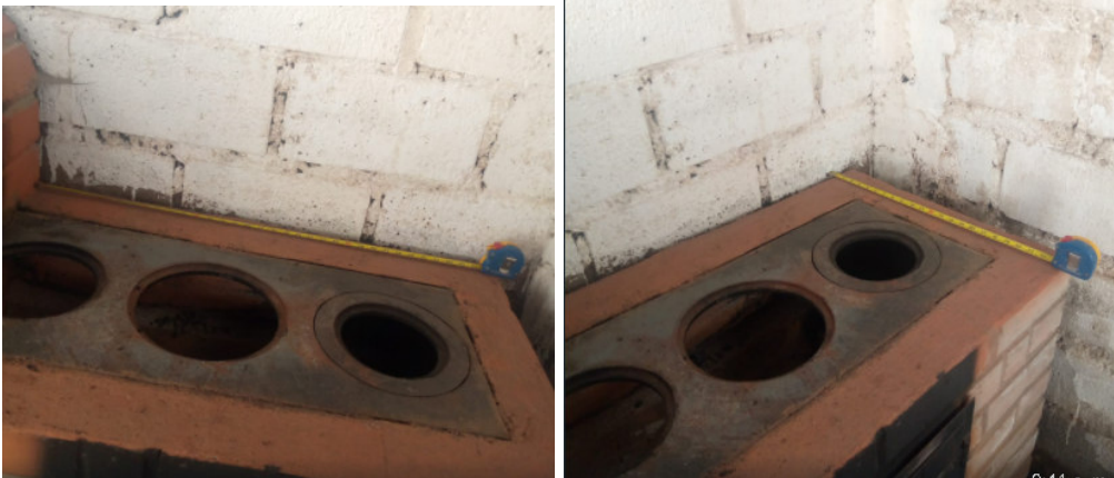
Verificación de medidas de la cocina ecoeficiente
