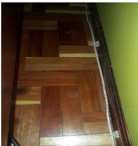
Figura 3.45 Transporte del cable Ethernet en el segundo piso
