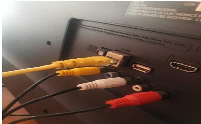
Figura 3.37 Puerto Ethernet de la televisión del primer piso
