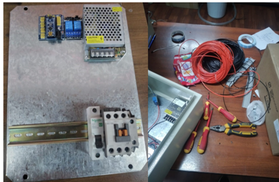
Figura 2.21 Materiales para armar el tablero de control
