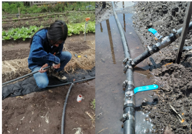
Figura 2.31 Instalación de la red de riego
