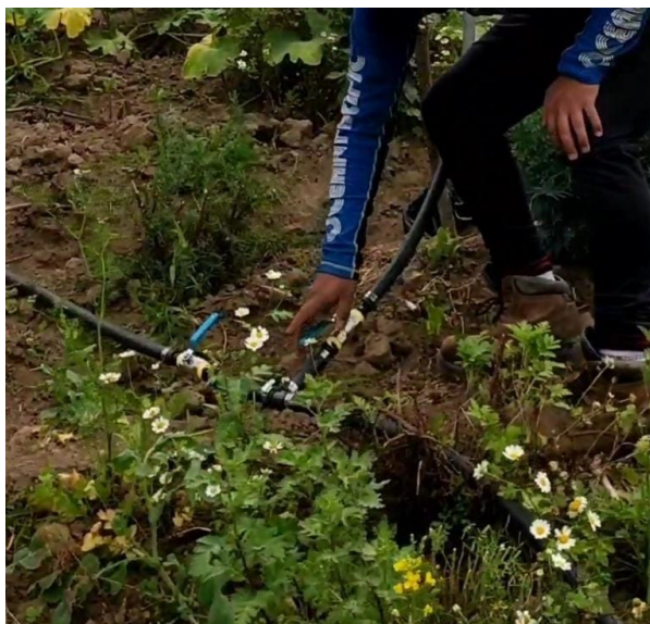
Figura 2.29. Instalación de válvulas en los ramales de aspersión
