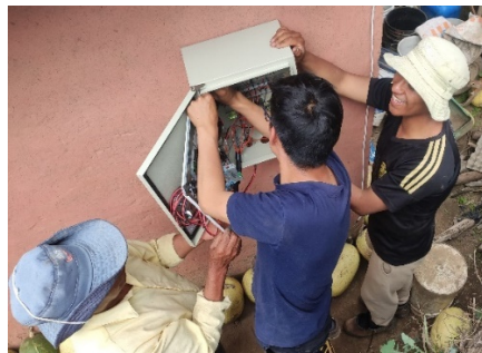
Figura 2.19. Instalación del gabinete eléctrico
