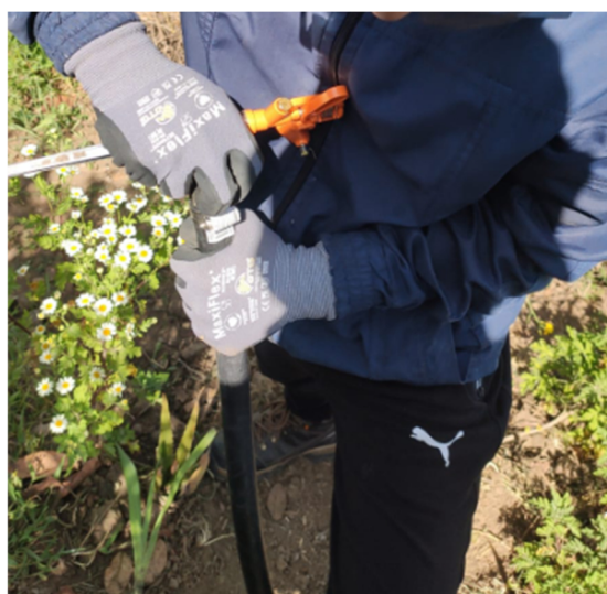
Figura 2.26. Instalación del aspersor
