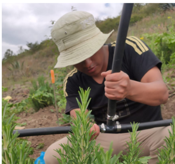
Figura 2.25. Instalación del ramal de aspersión
