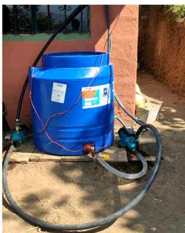
Figura 2.22. Instalación bomba-manguera
