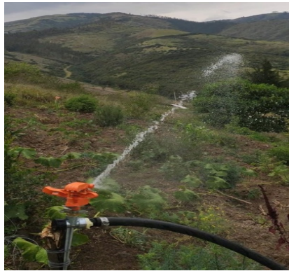
Figura 3.6. Prueba de presión y activación de aspersor en el punto critico
