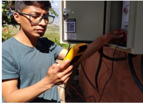
Figura 3.3. Prueba de cortocircuito en el tablero eléctrico
