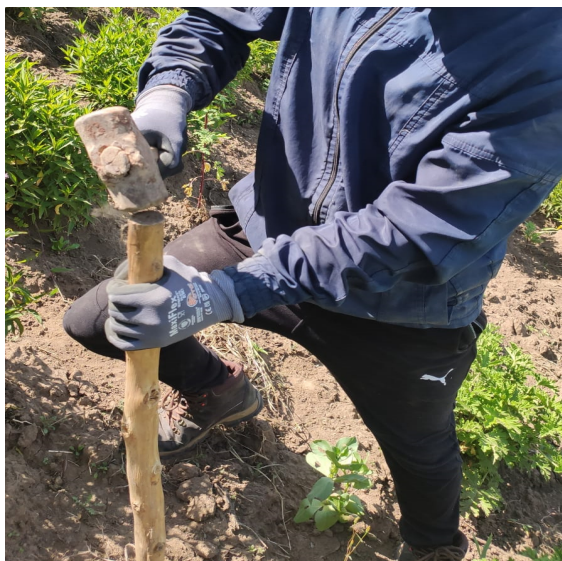
Figura 2.27. Colocación de estacas para suspender los aspersores
