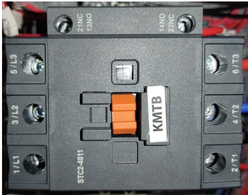
Figura 3.4. Contactor AC-3 marca SRTOM de 40 (A).
