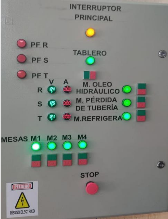
Figura 3.19. Etiquetado al exterior del tablero [8].
