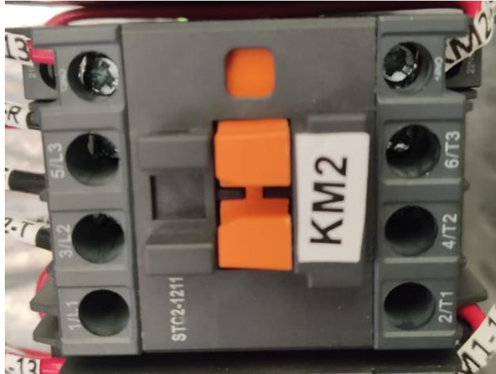
Figura 3.3. Contactor AC-3 de 12(A) marca STROM.
