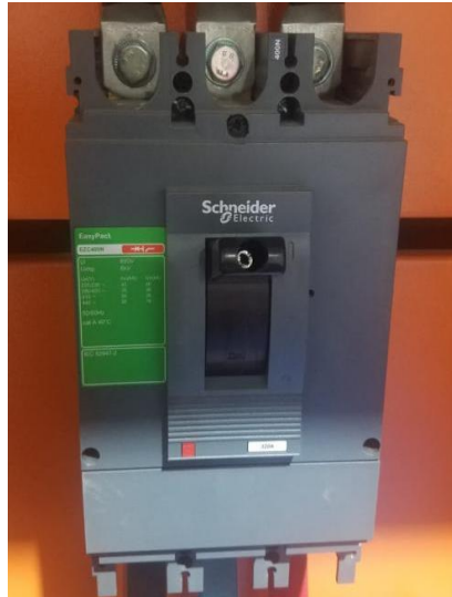
Figura 11: Disyuntor de caja moldeada.
