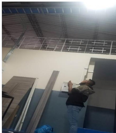
Figura 8: Uso del medidor laser para encontrar la longitud del conductor.
