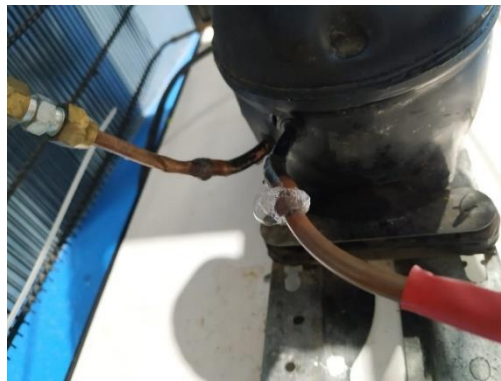
Figura 2.22 Prueba de burbujas con estanqueidad de nitrógeno
