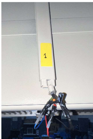
Figura 3.10 Conexión de sensor 1 a cable de instrumentación con capacitor de 0,1 (u)F
