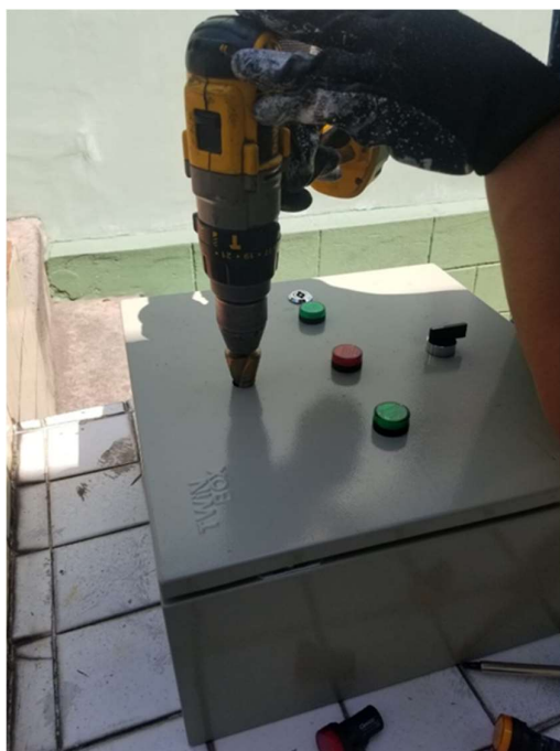
Figura 2.10 Perforación de gabinete para luces piloto.
