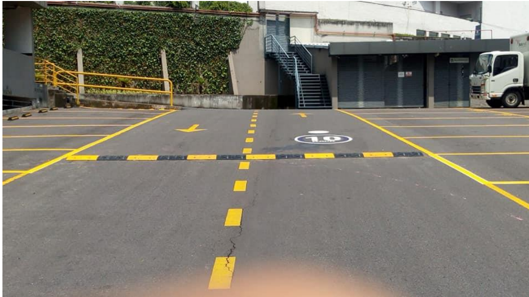
FIGURA 6. Pintura de alto tráfico Fuente: (Surblock Company S.A, 2020)
