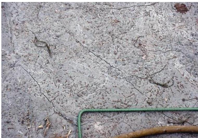
**Figura 2.** Grietas térmicas en losa gruesa.
