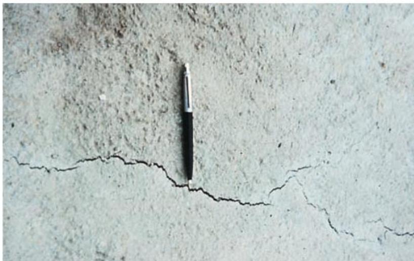
**Figura 1.** Grietas de contracción plástica en hormigón fresco.
