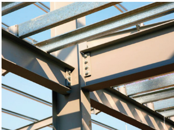
(2a) Conexiones de momento en SRCG
