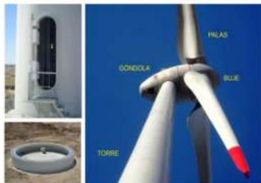
*Figura 15. Torre completa con aerogenerador tripala de eje vertical [13].*
