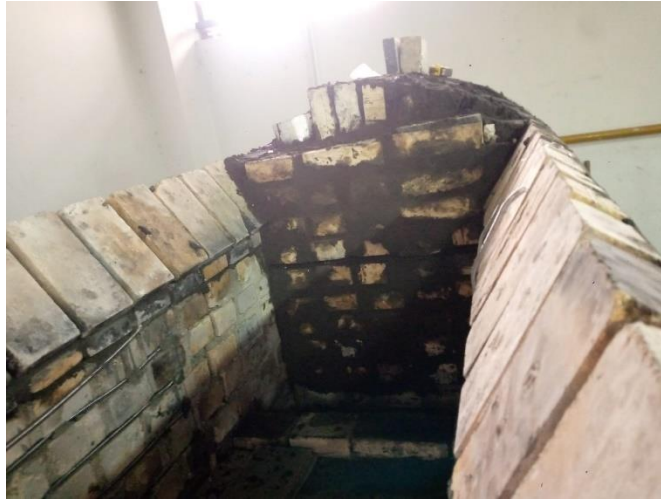
Figura 12. Paredes laterales con ángulo de la cúpula [Fuente: Propia].
