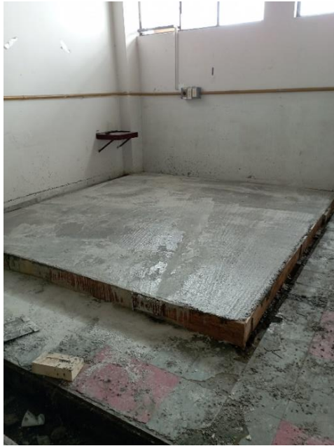
Figura 8. Base o replantillo de concreto [Fuente: Propia].
