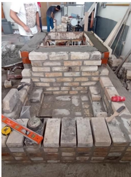
Figura 11. Construcción paredes de cámara secundaria [Fuente: Propia].
