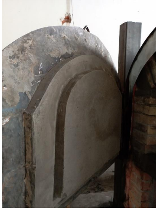
Figura 18. Armado de compuerta en soporte [Fuente: Propia].
