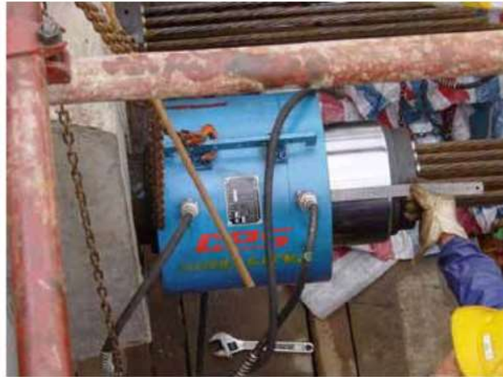
Figura 1.9. Gato para postensado de multitorones Fuente: CPS, 2019 [15].
