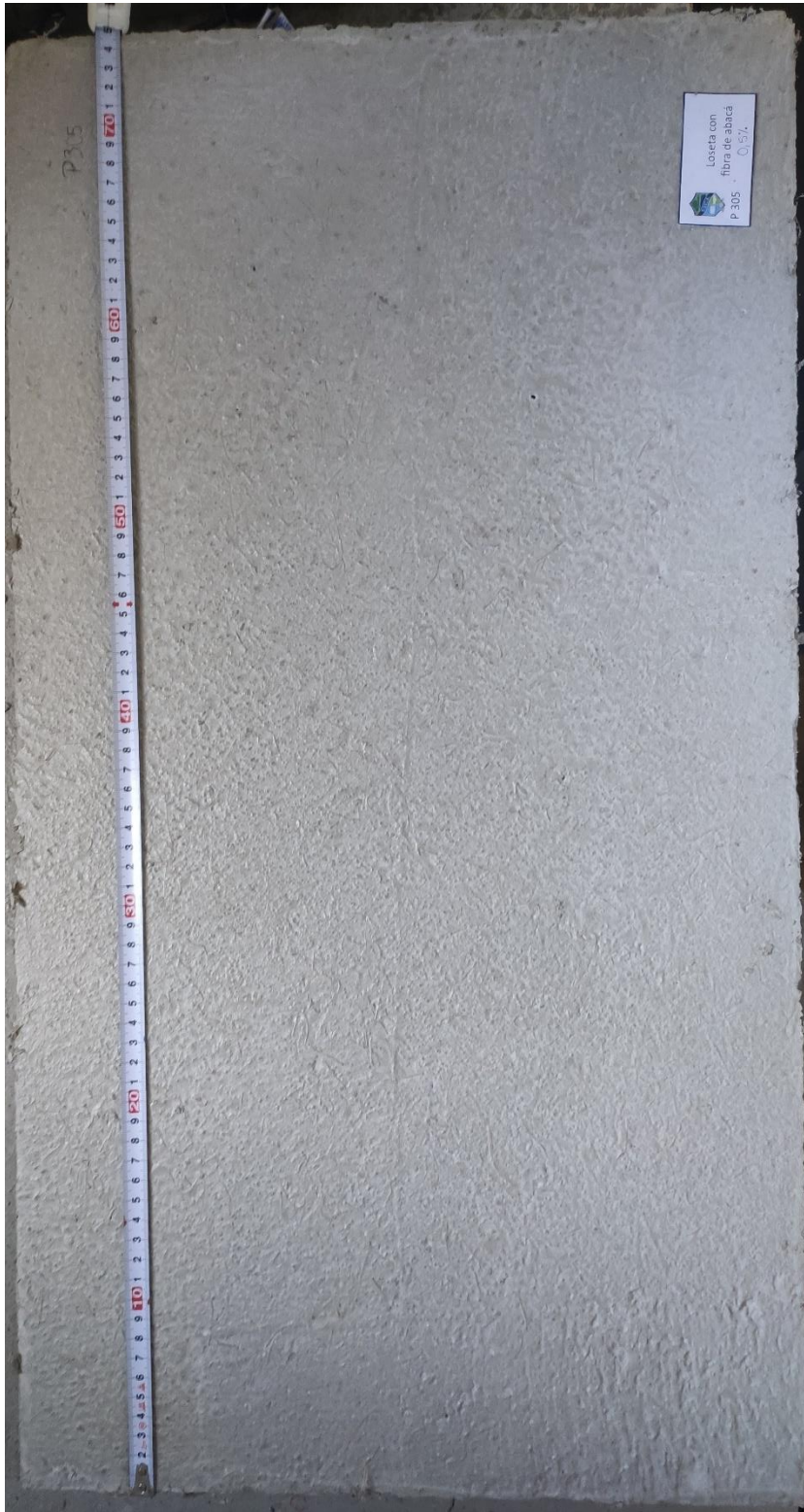
Loseta de hormigón con fibra P305. No presenta grietas.
