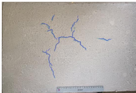
Figura 18. Fisuras en placas con dosificación 3.
