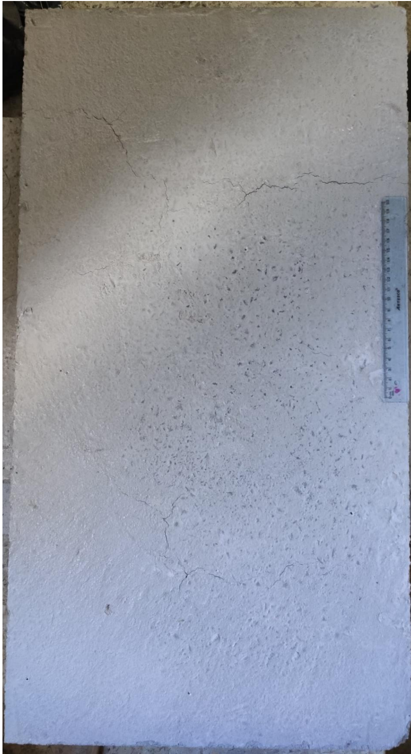
Loseta de hormigón E.31.
