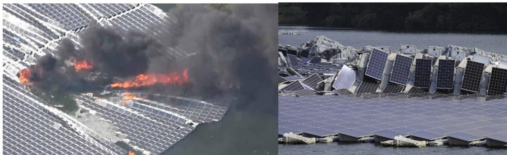
**Figura 1. 3.** Accidente Planta Solar Yamakura a causa del tifón Faxai, Japón 2019.
