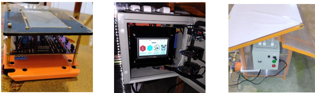
Figura 2. 15. Montaje final del sistema de control en la estructura.
