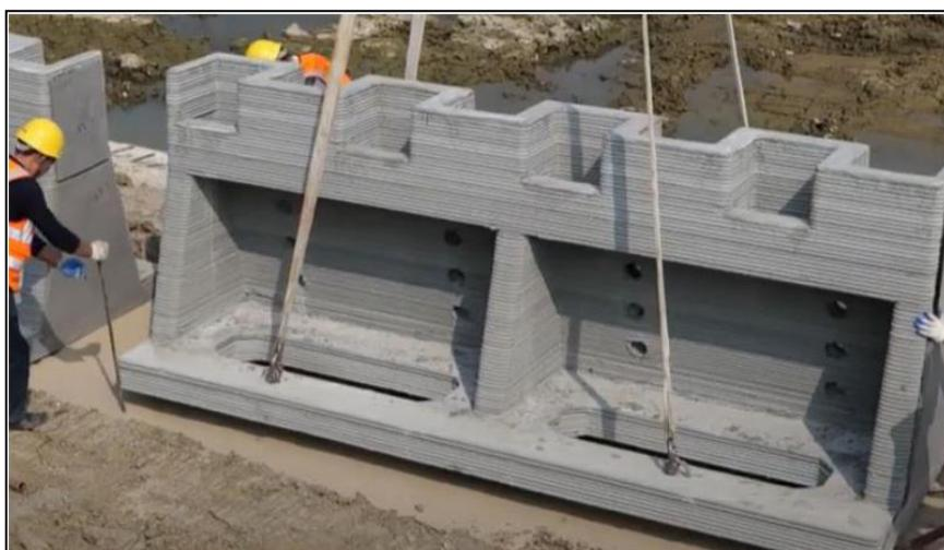
*Ilustración 6. Muro de contención-Hormigón Impreso*
