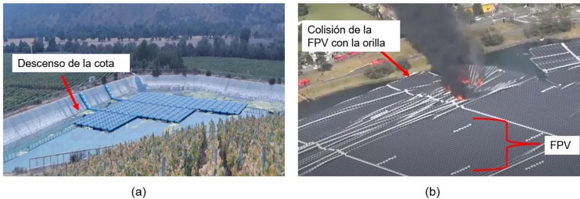
**Figura 1.3. Accidentes de una FPV.** (a) Descenso de cota y mala selección del sistema de amarre; (b) Colisión de una FPV con la orilla por fallo en conexiones de flotadores.
