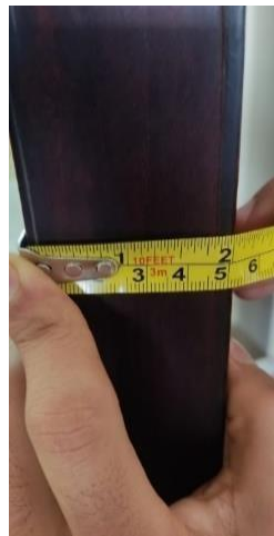
Figura 3.1. Medición de grosor de puertas en aulas
