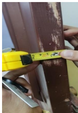
Figura 3.2. Medición de grosor de puertas en oficinas
