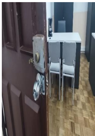
Figura 2.2. Cerradura deteriorada
