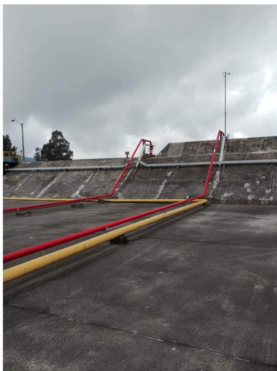
Figura 2.6 Líneas del sistema contra incendios
