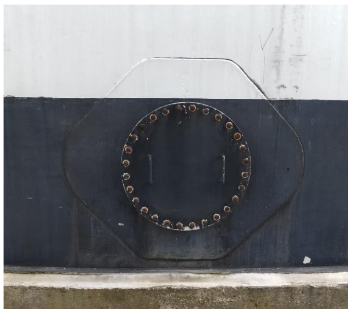
Figura 2.10 Manhole de limpieza convencional
