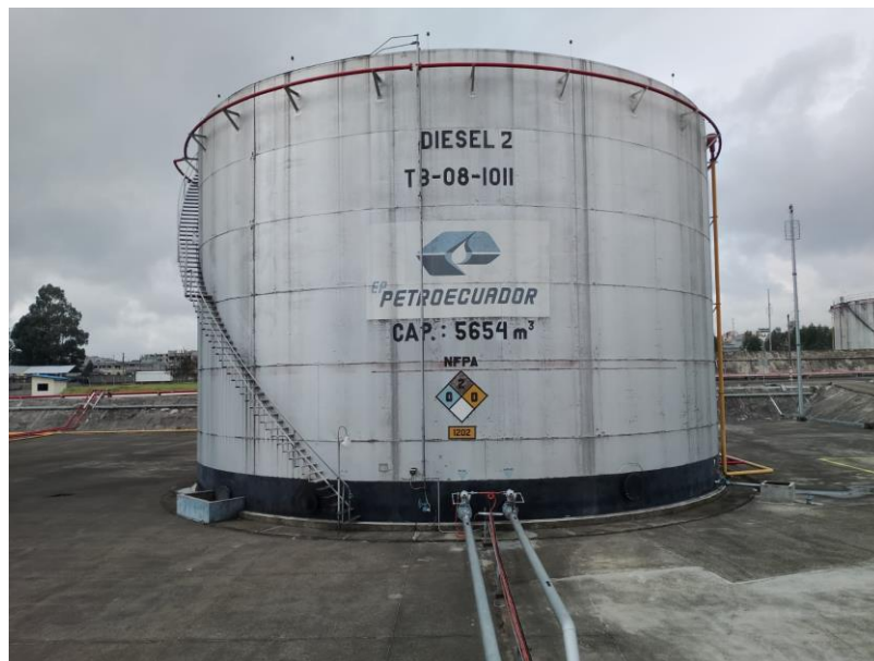
Figura 2.5 Sistema contra incendios
