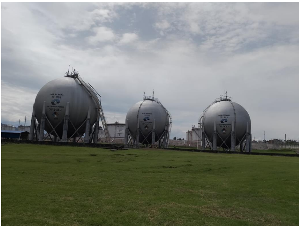
Figura 2.3 Tanques esféricos
