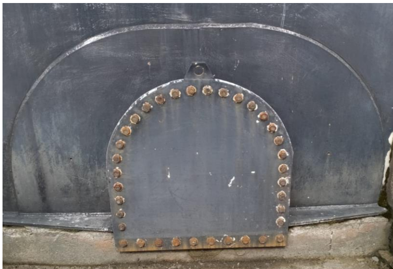
Figura 2.9 Manhole de limpieza tipo catedral
