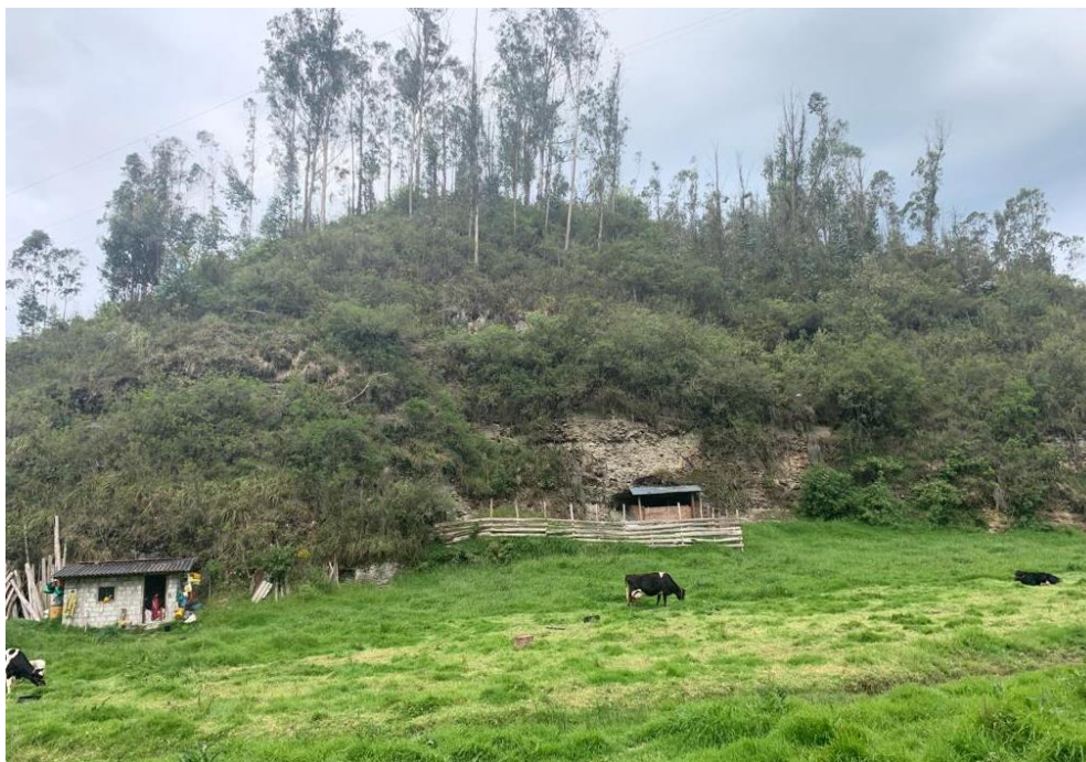
Ilustración 14. Explanación del Km 3+400 al Km 9+570 Fuente: Ministerio de Transporte y Obras Públicas
