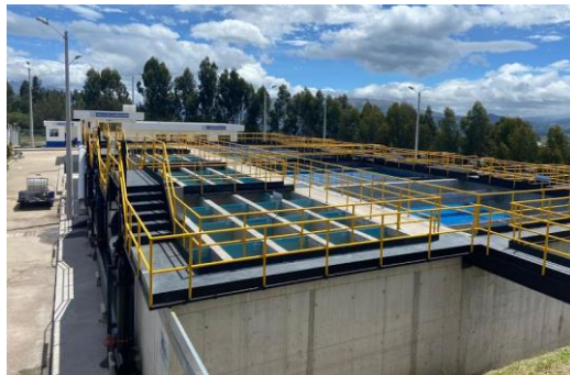
Figura 1. Planta de producción de agua potable “Huayco Machay”
