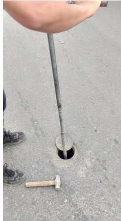
Figura 2: Verificando el estado de la caja de válvula
