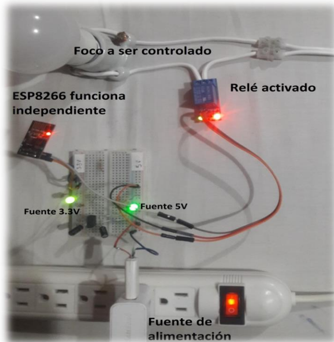
Figura 3.20. Sistema armado para pruebas
