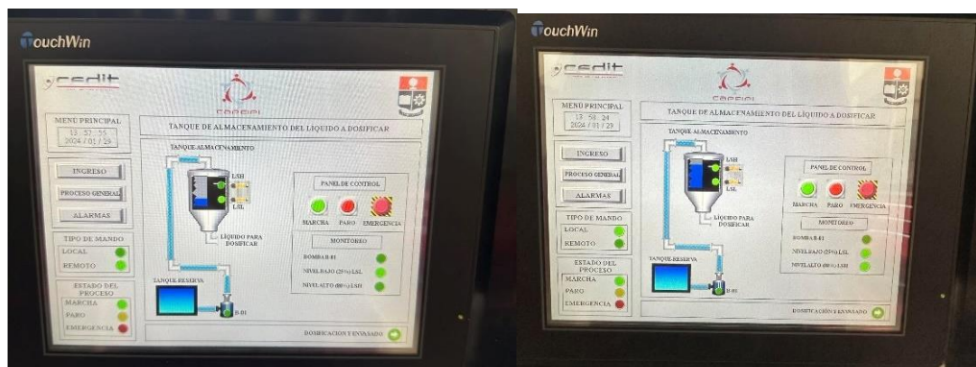
Figura 5.93. Llenado del tanque de almacenamiento.
