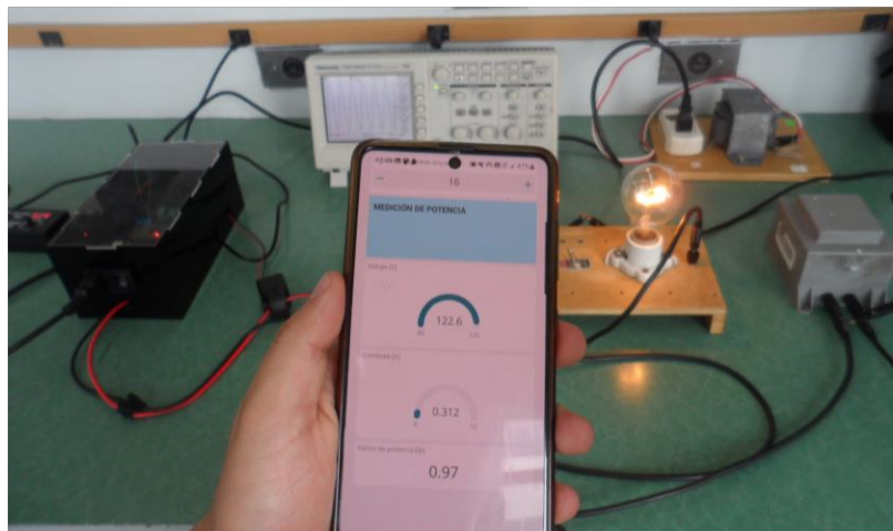
Figura 3.10. Medición de variables eléctricas con carga R – L
