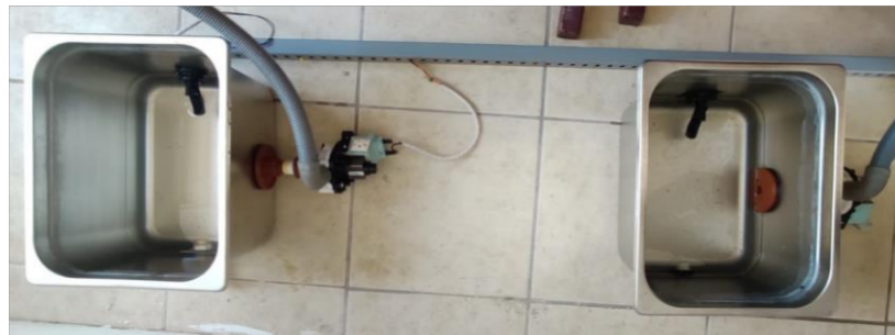
Figura 5.52. Tanques de reserva vacíos.
