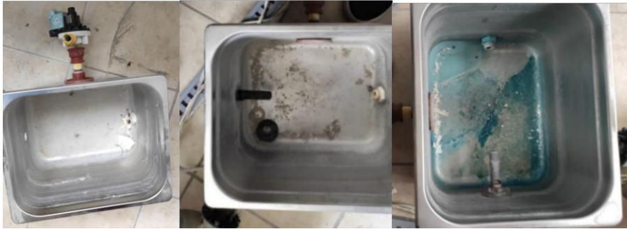
Figura 2.5. Estado de los tanques de reserva del módulo.
