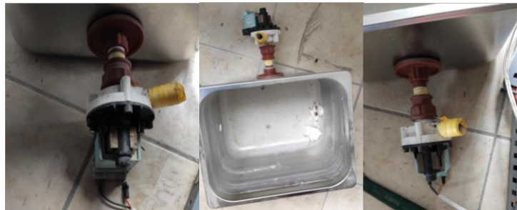
Figura 2.6. Bombas del módulo antes del mantenimiento.
