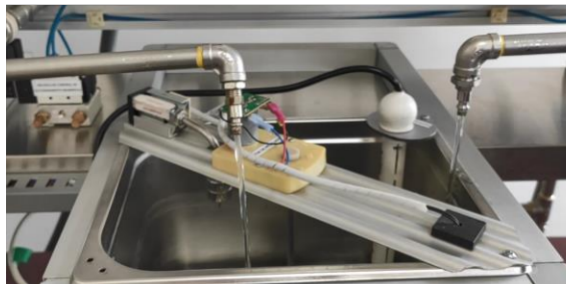
Figura 3.12. Llenado del tanque de mezclado.
