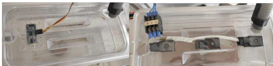
Figura 2.4. Parte superior de los tanques de almacenamiento.
