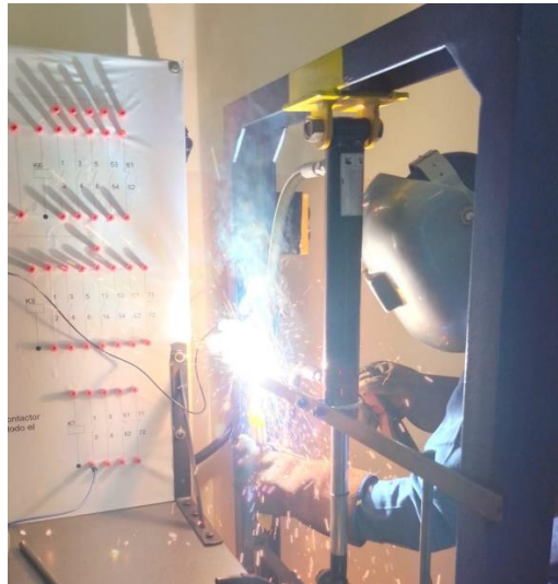
Figura 2.22 Soldadura de la fijación
