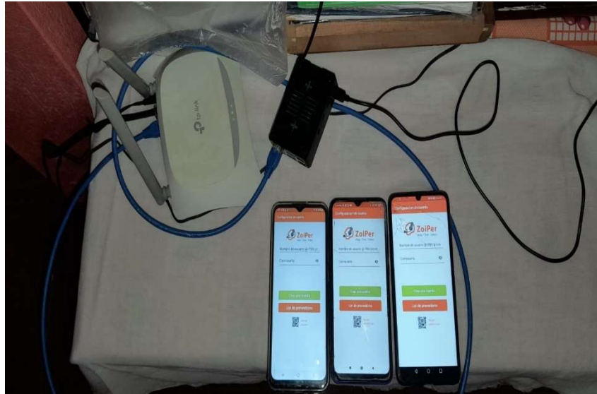
Figura 3.52. Central telefónica privada PBX
