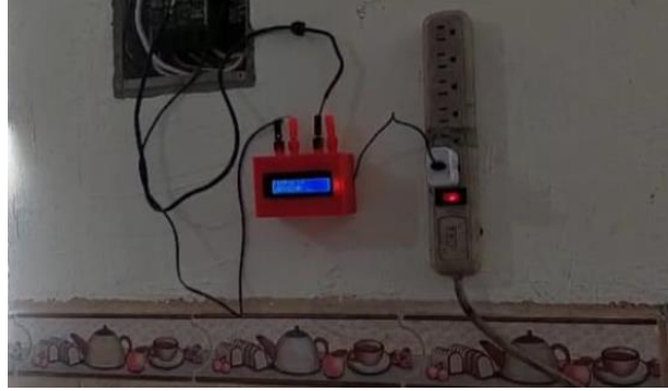
Figura 0.41 Instalación del Sistema
