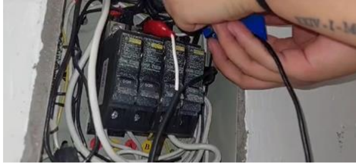
Figura 0.38 Conexión de la pinza
