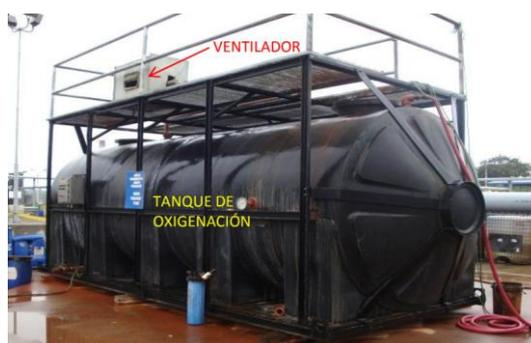
**Figura 2.51.** Tanque de oxigenación de la planta de Bajo Alto
