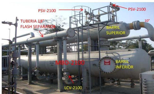
**Figura 2.48.** Separador de gas y condensados de la planta de Bajo Alto
