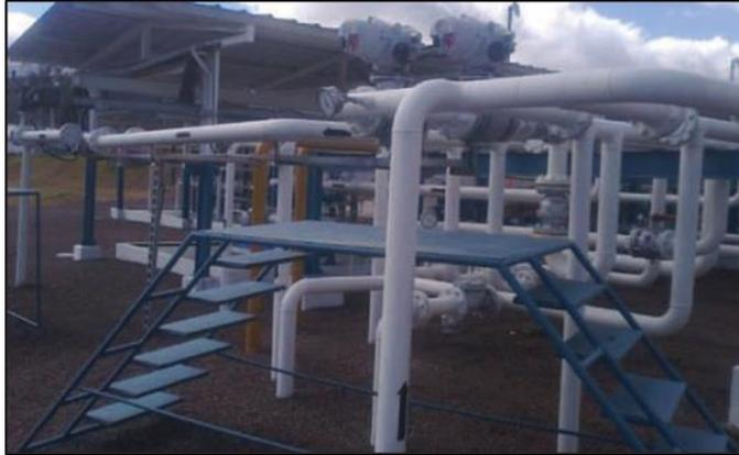
**Figura 2.86.** Manifold de distribución Oyambaro
