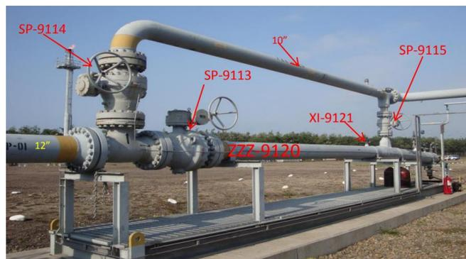
**Figura 2.47.** Recibidor del limpiador de la planta de Bajo Alto
