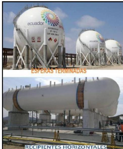
**Figura 2.72.** Esferas y recipientes horizontales de almacenamiento de GLP
