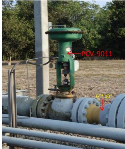
**Figura 2.54.** Válvula reguladora de presión de la planta de Bajo Alto
