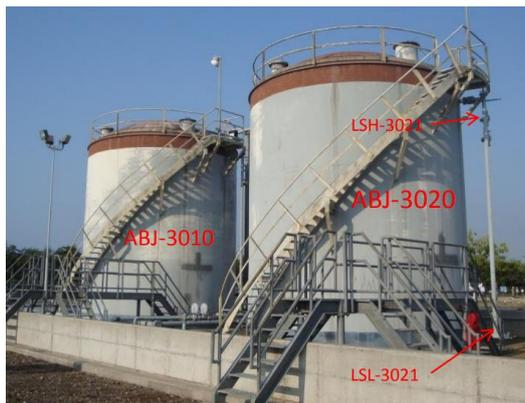
**Figura 2.50.** Tanques de condensados de la planta de Bajo Alto
