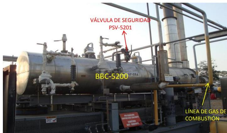
**Figura 2.60.** Rehervidor de glicol de la planta de Bajo Alto
