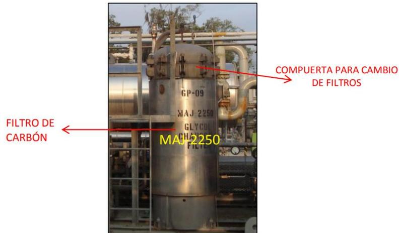
**Figura 2.63.** Filtro de carbón de la planta de Bajo Alto
