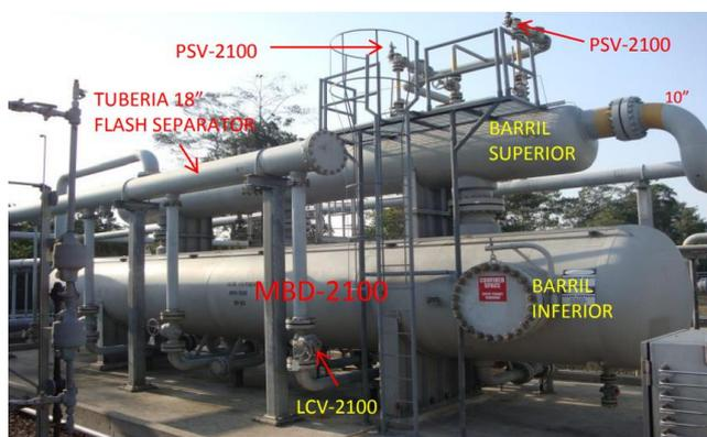
**Figura 2.49.** Separador atmosférico de condensados de la planta de Bajo Alto
