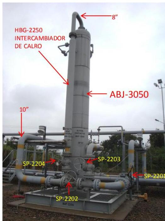
**Figura 2.53.** Torre contactora de glicol de la planta de Bajo Alto
