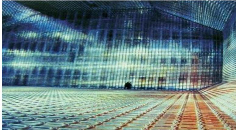
**Figura 2.12.** Interior de un tanque de membrana
