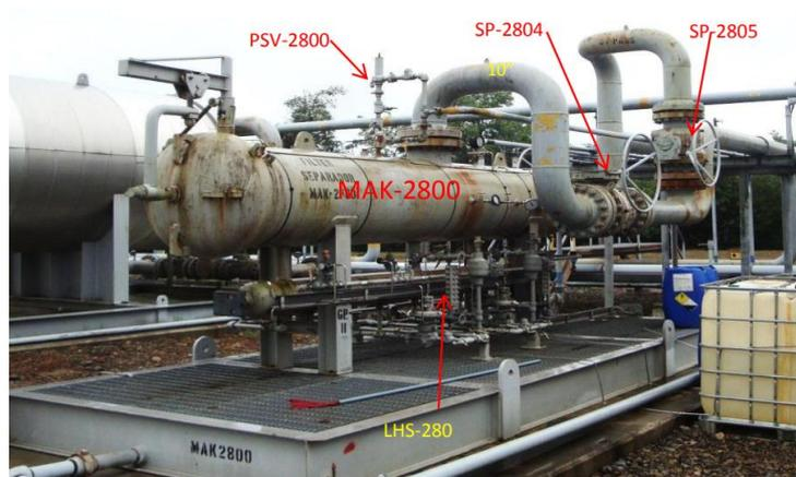
**Figura 2.55.** Filtro separador de la planta de Bajo Alto
