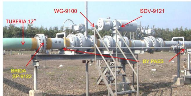
**Figura 2.46.** Tubería de ingreso de gas de la planta de Bajo Alto
