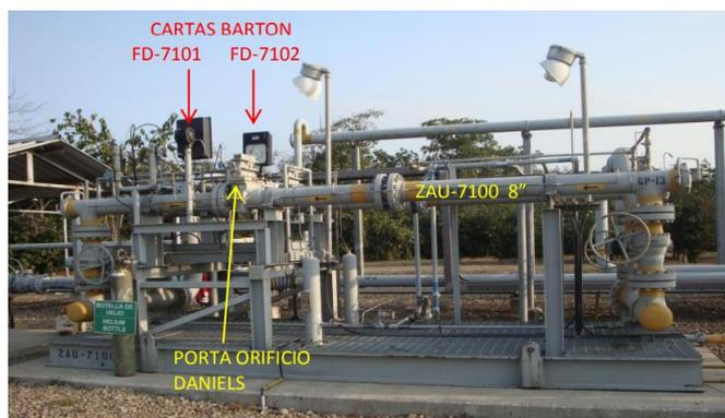
**Figura 2.57.** Medidor de gas de la planta de Bajo Alto
