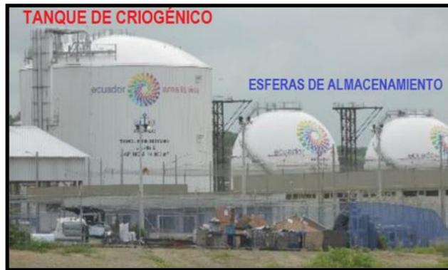
**Figura 2.71.** Tanque criogénico y esferas de almacenamiento de GLP
