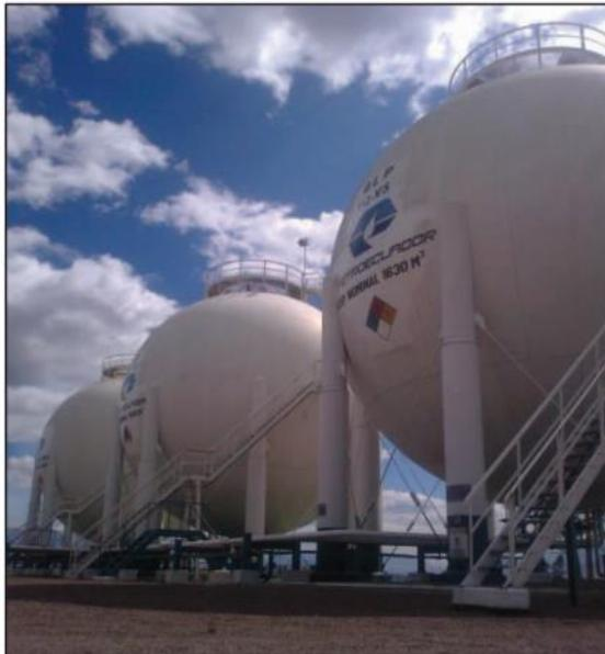
**Figura 2.87.** Esferas presurizadas de almacenamiento de GLP Oyambaro
