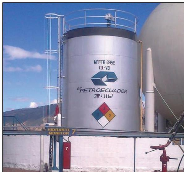
**Figura 2.89.** Tanque atmosférico Slop Oyambaro
