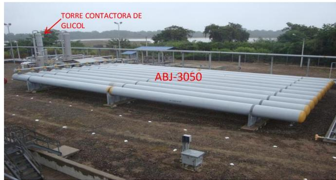
**Figura 2.52.** Condensadores de presión de la planta de Bajo Alto
