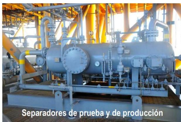
**Figura 2.41.** Separadores de prueba y de producción de la Plataforma AMS - A
