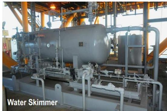
**Figura 2.42.** Water Skimmer de la Plataforma AMS - A
