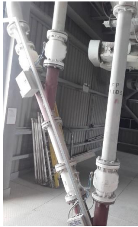
Figura 1.9. Válvula de pinzas en la construcción.
