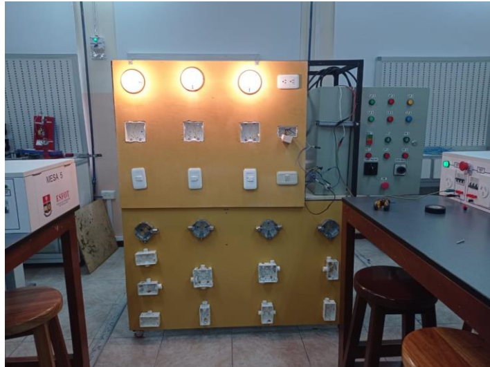
Figura 3.19 Circuito 3 implementado en el módulo de canalizaciones
