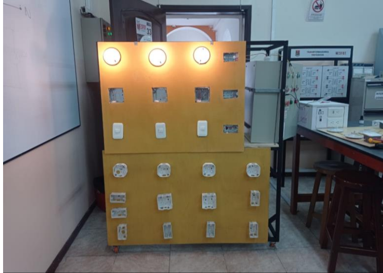
Figura 3.13 Circuito 1 implementado en el módulo de canalizaciones
