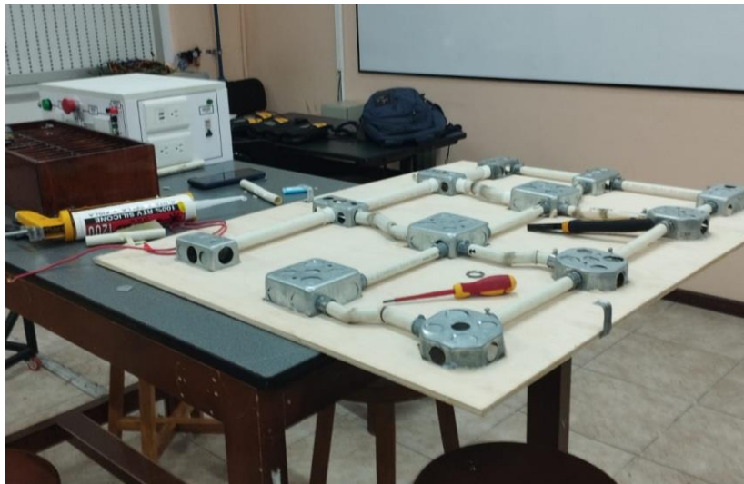
Figura 3.5 Doblado de tubería
