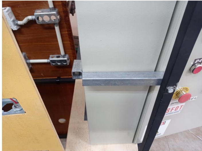
Figura 3.7 Montaje del tablero eléctrico
