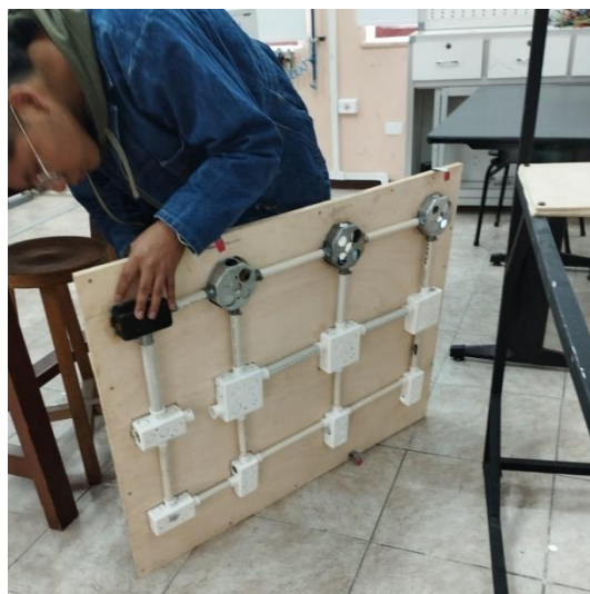
Figura 3.4 Instalación de tubería
