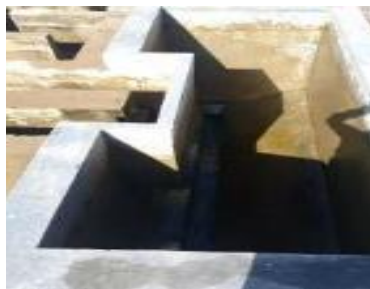
Figura 16. Tanque de recepción de agua del sedimentador en limpieza
