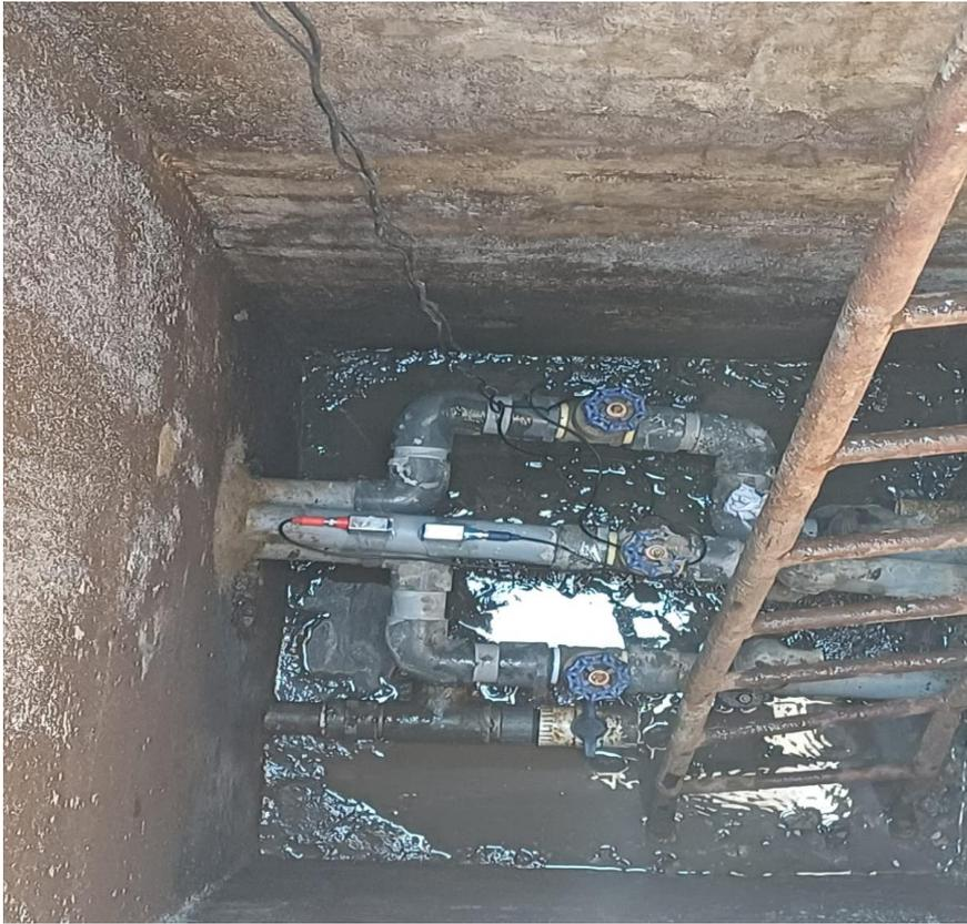
**Colocación de flujómetro ultrasónico en la tubería de distribución**
