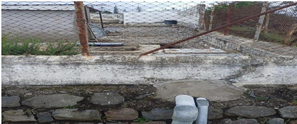
**Salida de tubería de distribución desde tanque de almacenamiento**
