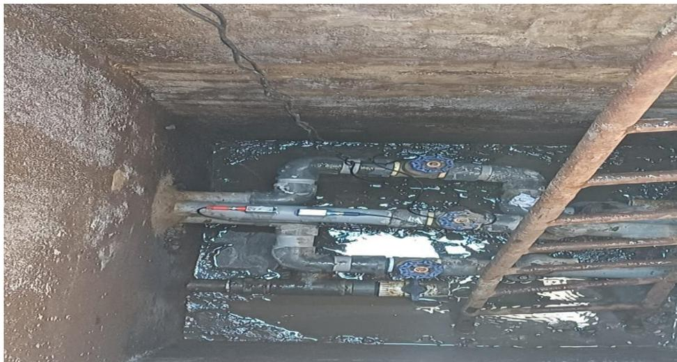
**Colocación de flujómetro ultrasónico en la tubería de distribución**
