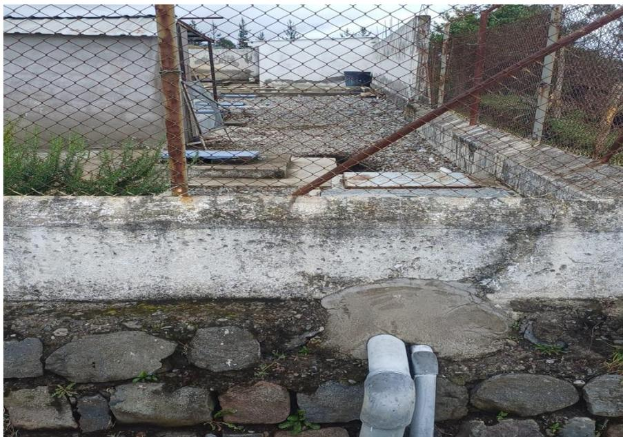
**Salida de tubería de distribución desde tanque de almacenamiento**
