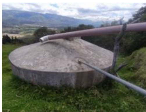
Figura 3.5. Tanque de almacenamiento secundario existente
