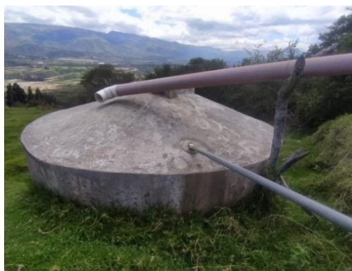
Figura 2.10. Tanque de almacenamiento cónico
